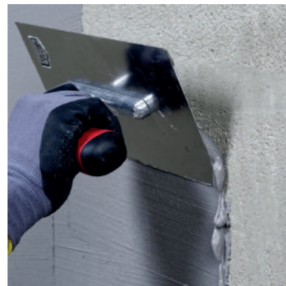
Een contactlaag kan ook als schraaplaag aangebracht worden.
