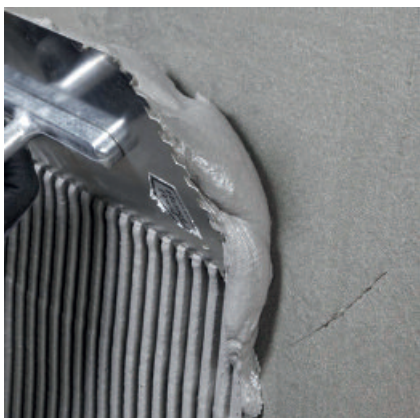
PCI Barraseal Turbo moet in minimaal 2 lagen worden aangebracht. Ter controle van de laagdikte kan het materiaal opgekamd en daarna glad gemaakt worden.
