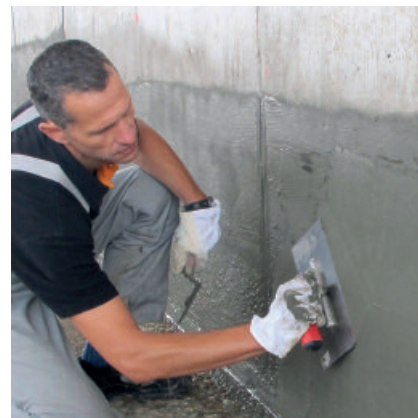
PCI Barraseal is plastisch smeug. Poriën en verdiepingen worden eenvoudig en snel dichtgesmeerd.
