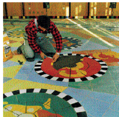
Een goede verlijming met PCI Flexmörtel.
