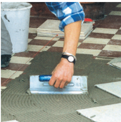
Na ca. 30 tot 45 minuten kan keramiek worden verlijmd met een PCI-tegellijm.
