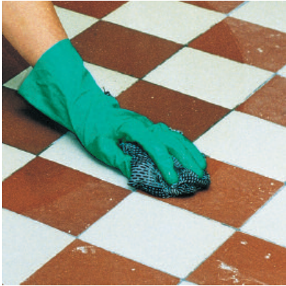
Ondergrond met een geschikt reinigingsmiddel reinigen zodat hechtingsverstoringen worden verwijderd.
