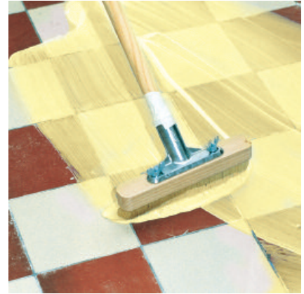
De primer met volledige dekking over de ondergrond verdelen door kruislings te werken.
