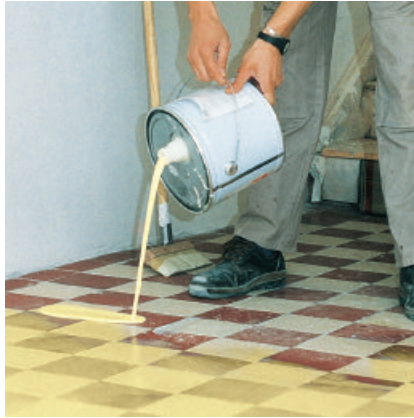
PCI Gisogrund 303 goed doorschudden of mengen en over de ondergrond uitgieten.
