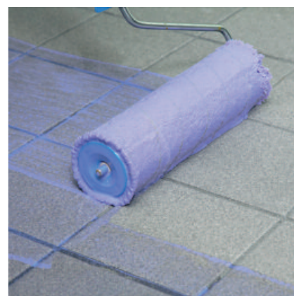
PCI Gisogrund 404 met controlekleur violet zorgt voor een goede hechting van egalisiemortels of tegellijmen met de ondergrond.
