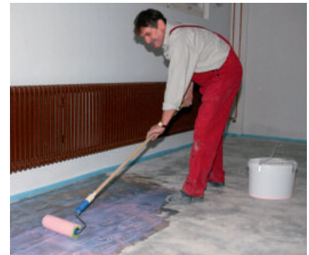
PCI Gisogrund Rapid wordt met een fijne schuimroller onverdund en gelijkmatig op de minerale ondergrond aangebracht. Na de verfilming kan meteen verder worden gewerkt.
