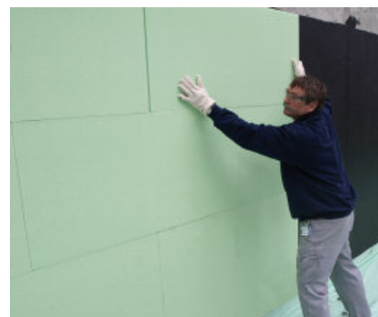
Door middel van schuiven plaatsen van isolatieplaten in het lijmbed van PCI Pecimor DK.
