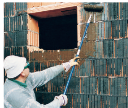
PCI Pecimor F, 1 : 5 met water verdund, als grondering voor bitumenafwerkklagen.
