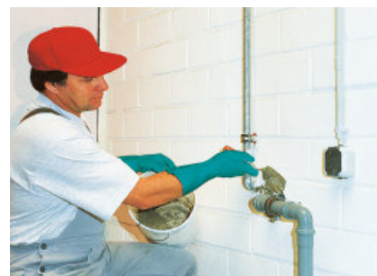
Snelciment PCI Polyfix 5 Min. is eenvoudig te verwerken en hoeft alleen met water te worden aangemaakt.
