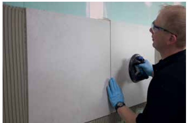
...en hebben een zeer goed standvermogen, ook bij grootformaat tegels op de wand.
