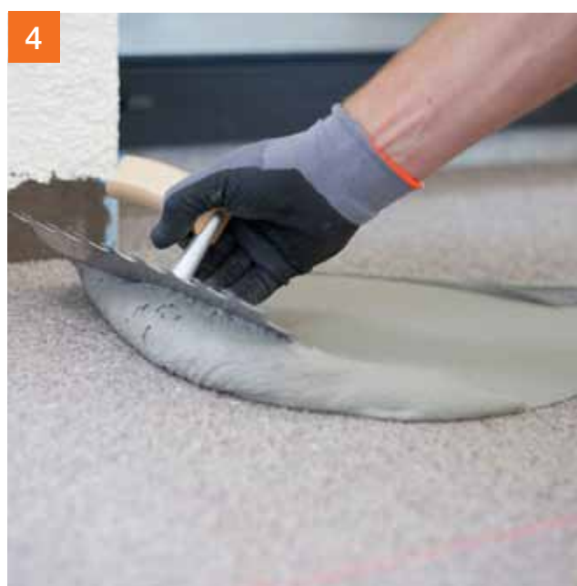
4 PCI Flexmörtel® S2 Rapid als schraaplaag aanbrengen
