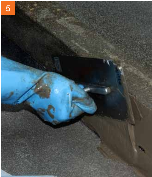
5 PCI Apoflex® aanbrengen als lijm voor kimband ...
