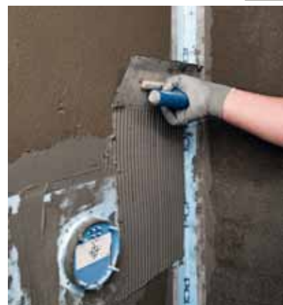
Afdichten en tegels lijmen
