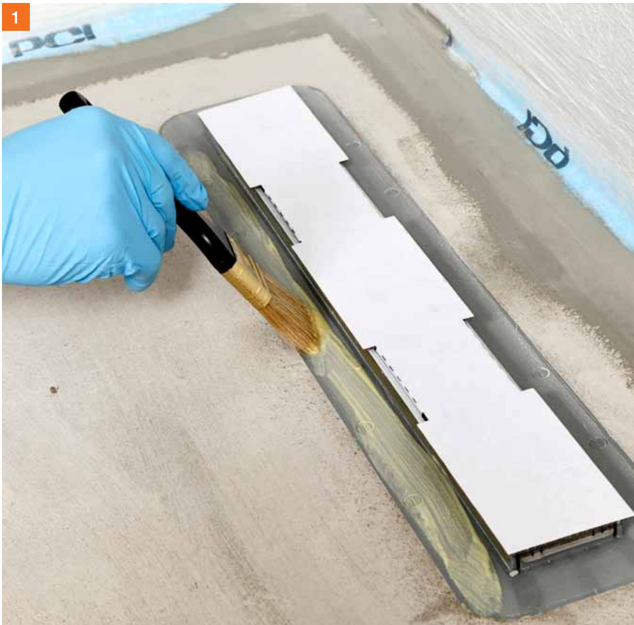
Gronderen van de aansluitflens met PCI Gisogrunder® 303 of PCI Gisogrunder® 404 bij matige waterbelasting, bij hoge belasting met PCI Epoxigrunder.
