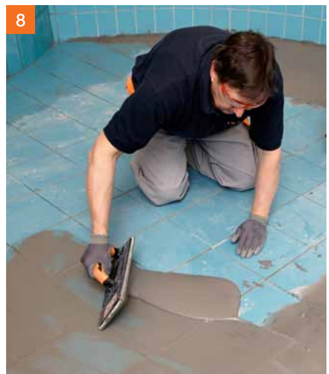
De volgende dag wordt er gevoegd, bijvoorbeeld met PCI Durafug® NT. Breng de voegmortel aan ...
