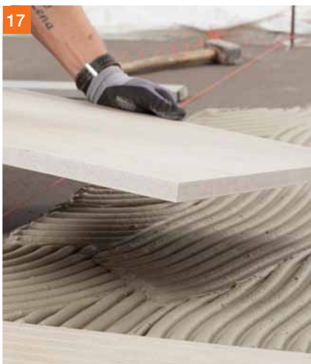
Tegel in het lijmband leggen
