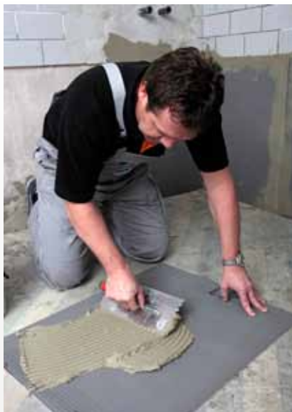
Breng de tegellijm met een lijnkam aan op de achterzijde van de platen. Gebruik bij grote oneffenheden eventueel de dottenmethode.
