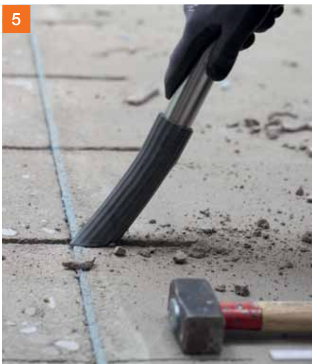
Losse delen met een industriezuiger verwijderen
