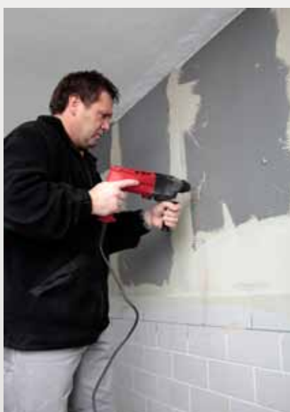
Nadat de tegellijm is uitgehard, boort u de gaten voor de pluggen (ca. 5 stuks/m 2 ).
