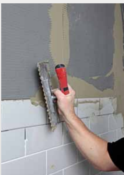
Vlak de stoot- en aansluitnaden uit met tegellijm. Leg zo nodig glasvezelweefsel in de spachtellaag, bijv. PCI Gewebbahn.
