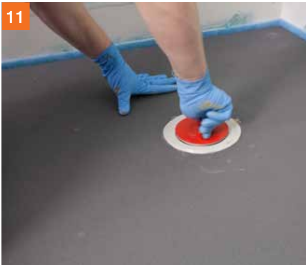
11 ... schroef vervolgens de PCI Pecibord* met bouwdop vast op de vloerafvoer. Bouwdoppen zorgen ervoor dat de vloerafvoer niet verontreinigd wordt bij de volgende arbeidsstappen.
