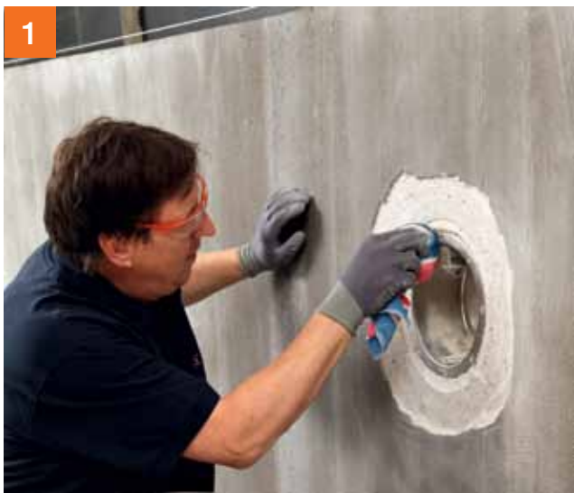
1 Professionele optie: Klemflens met dichtmanchet.
