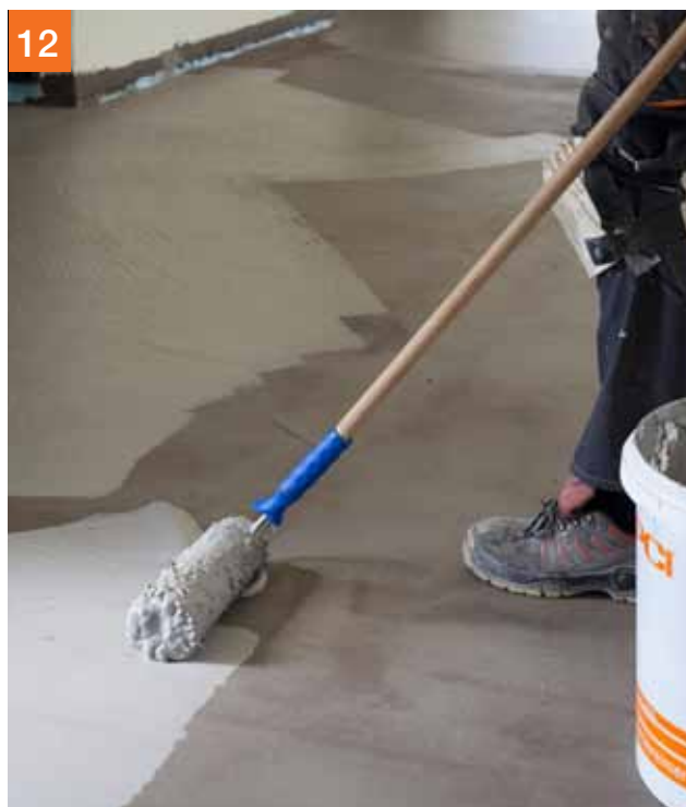
12 PCI Seccoral® 2K Rapid als eerste laag met een vachtroller aanbrengen
