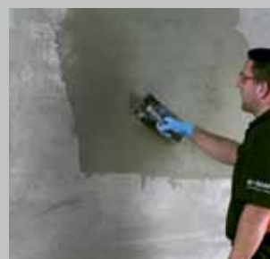
Ondergrondvoorbereiding voor het betegelen van de vloer en wand met grootformaat tegels en platen
