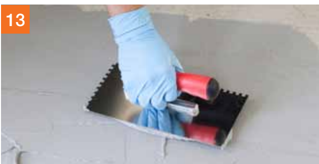
13 Contactlaag van PCI Seccoral® 2K Rapid aanbrengen
