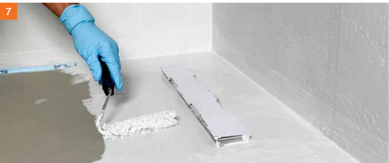
De tweede laag kan na ca. 1 uur worden aangebracht.
