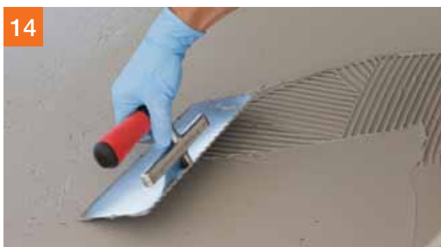
14 PCI Seccoral® 2K Rapid met 6 mm lijnkam opkammen en daarna glad smeren
