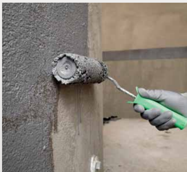
Tip: Breng de verdunde PCI Seccoral® 2K Rapid met een roller aan. Alle overige arbeidsstappen kunt u terugvinden in het hoofdstuk "Ondergronden goed afdichten en tegels lijmen" vanaf pagina 40.
