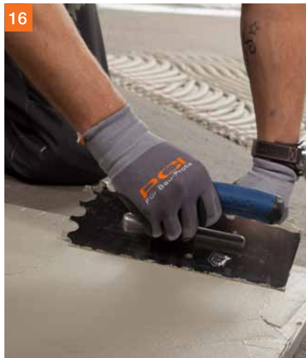
Contactlaag van PCI Flexmörtel® S2/S2 Rapid op de rugzijde van de tegel aanbrengen
