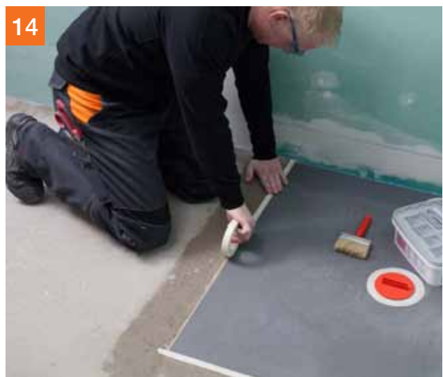
14 Tip: Plak de ontkoppelende randstroken met plakband af. Dan kan daar geen afdichtingspasta in lopen.
