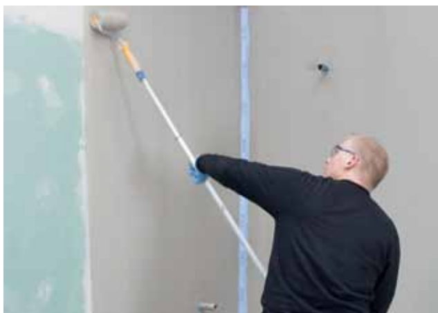
Smeerbare afdichtingen moeten altijd minimaal in 2 lagen worden aangebracht.
