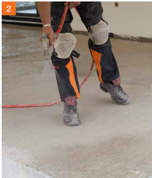
Ondergrond voorbevochtigen voor het aanbrengen van de uitvlakmortel
