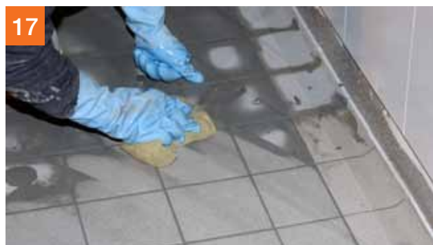
17 en na korte wachttijd wassen en schoon afwerken.
