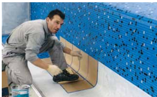
... wordt keramiek duurzaam op staalconstructies aangebracht.
