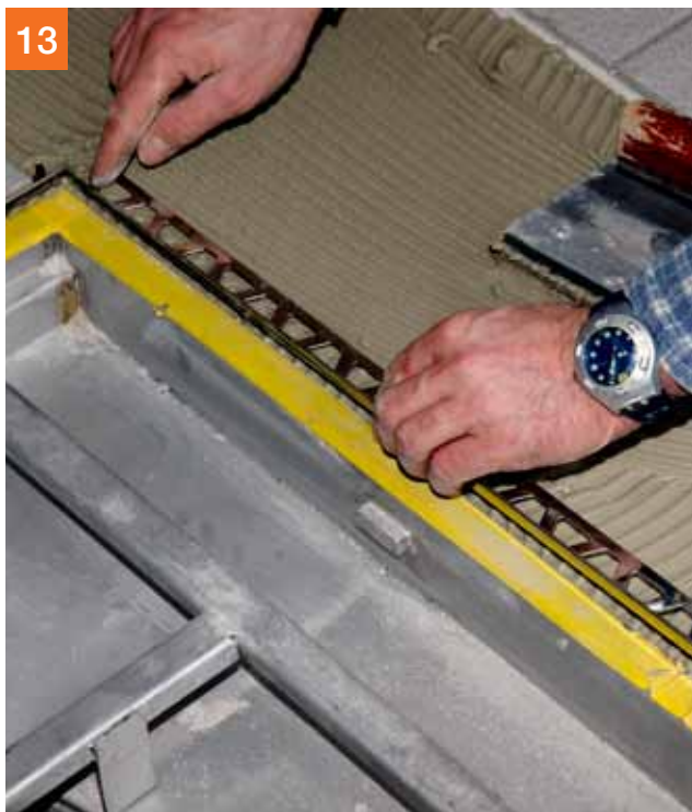
13 Zo nodig profielen in de lijm inbedden
