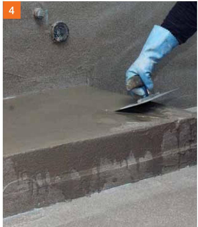
4 De eerste laag PCI Apoflex® F.
