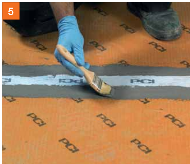
5 ... in combinatie met kimband PCI Pecitape® 120 afdichten .
