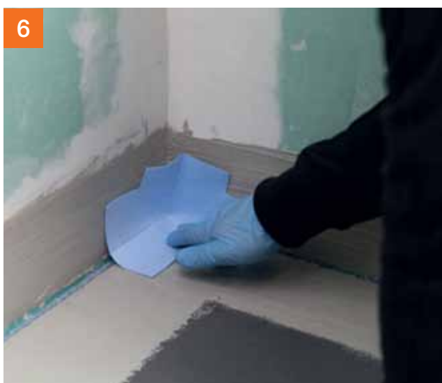
6 Leg de speciale binnenhoek PCI Pecitape® 90° I in het PCI Lastogum®.
