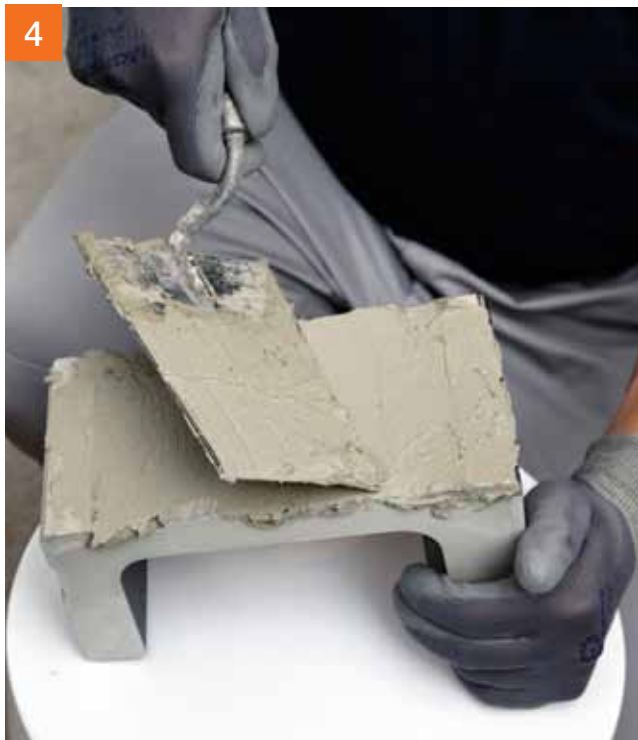
Breng op de achterkant van de randsteen lijm aan ...
