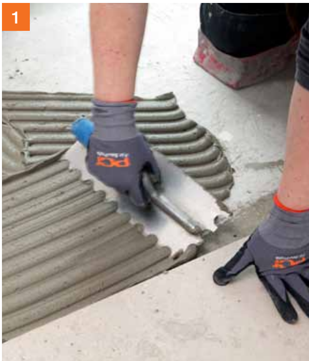
1 Opkammen van de natuursteenlijm (bijvoorbeeld PCI Carrament) met middenbedvertanding
