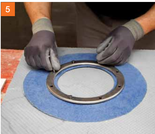
5 Vervolgens worden de schroeven geplaatst. Nu kan de set op stevig karton worden omgedraaid.
