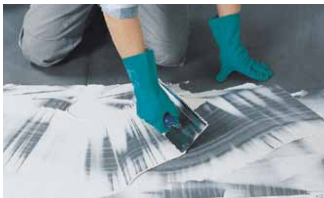
Met de vervormbare reactieharstegelijm PCI Collastic® ...
