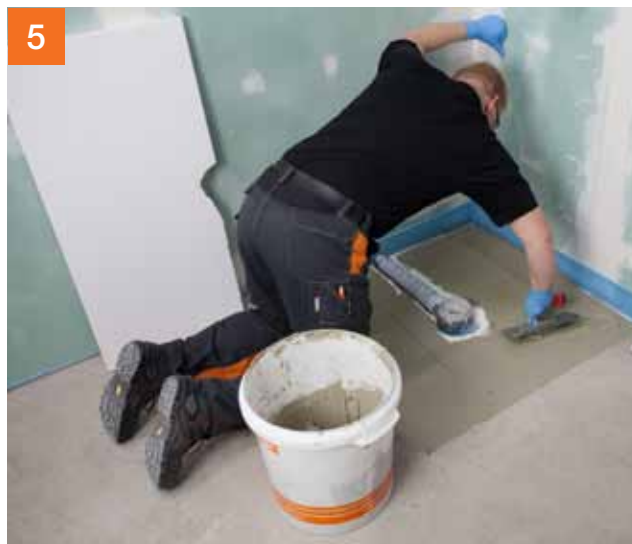
5 Pas de hoogte aan met hardschuimplaten van polystyrol van de juiste dikte.
