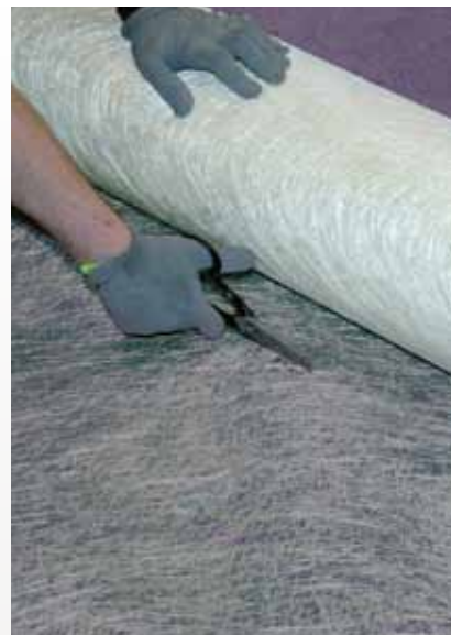
Knip de glasvezelmat met een schaar op maat en leg of rol deze op de gegrondeerde ondergrond.
