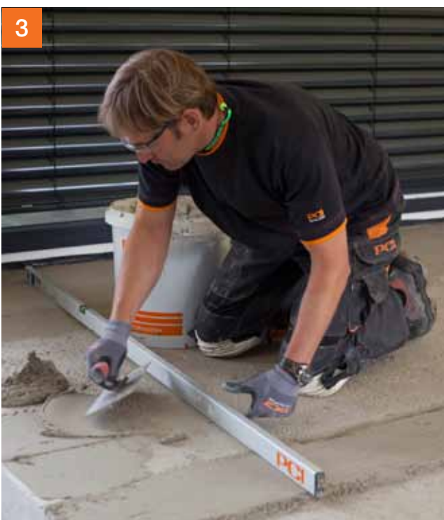
Uitvlakken met PCI Pericret®
