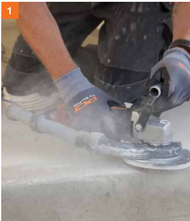
Ondergrondvoorbehandeling: oneffenheden verwijderen
