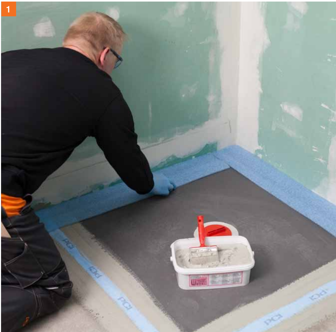
Aanbrengen van een ontkoppelingsstrook om contactgeluid te voorkomen.
