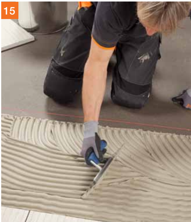
PCI Flexmörtel® S2 of PCI Flexmörtel® S2 Rapid opkammen
