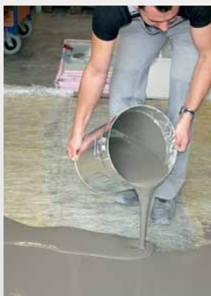
Giet de egalisatiemortel PCI Periplan® Extra in een minimumdikte van 10 mm uit.
