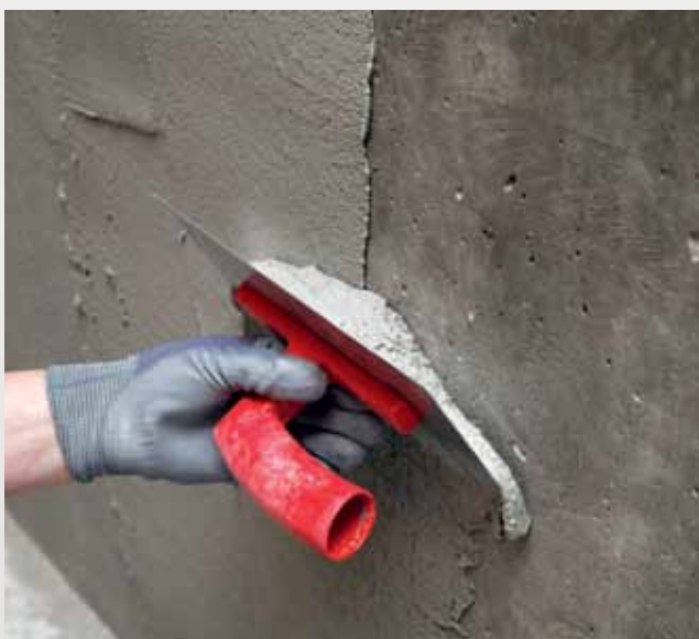
Vlak het oppervlak uit met PCI Pericret® of met PCI Nanocret® R2.
