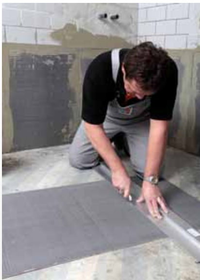
Snij de PCI Pecidur®-bouwplaten met een mes op maat.
