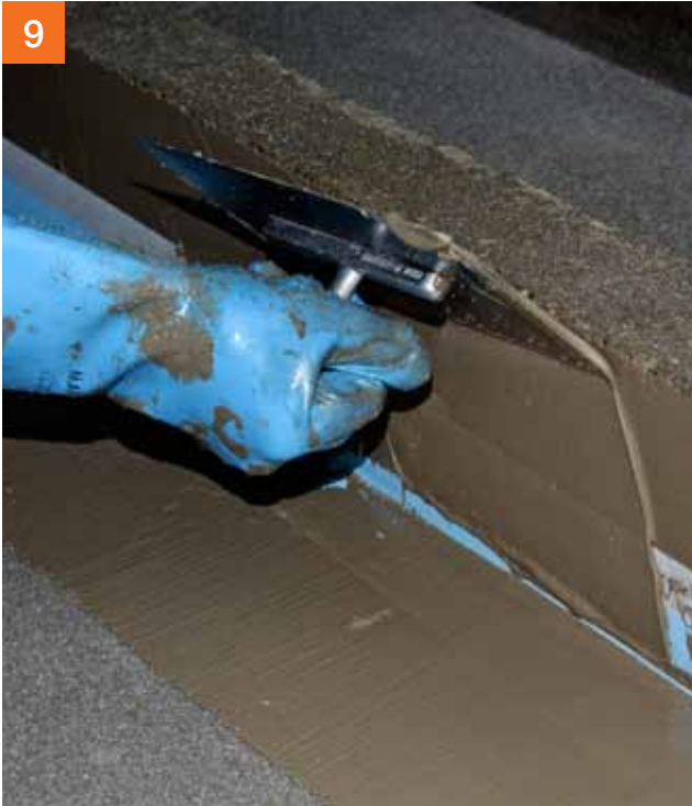
9 Nogmaals met PCI Apoflex® afwerken
