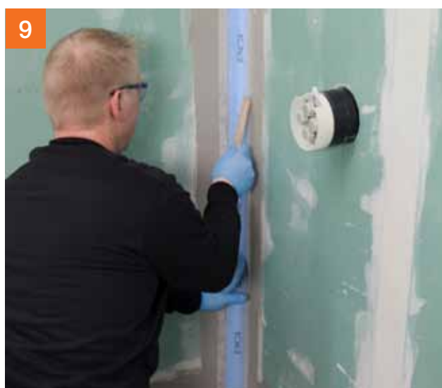
9 Dezelfde arbeidsstappen moeten ook bij verticale binnenhoeken, zoals aansluitingen wand/wand worden doorlopen.
