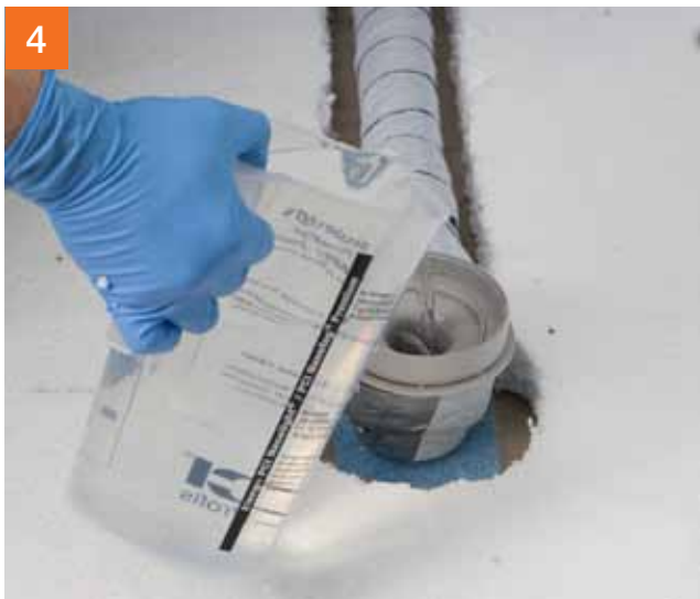
4 Voer een waterdichtingstest uit voordat u met de andere werkzaamheden begint.
