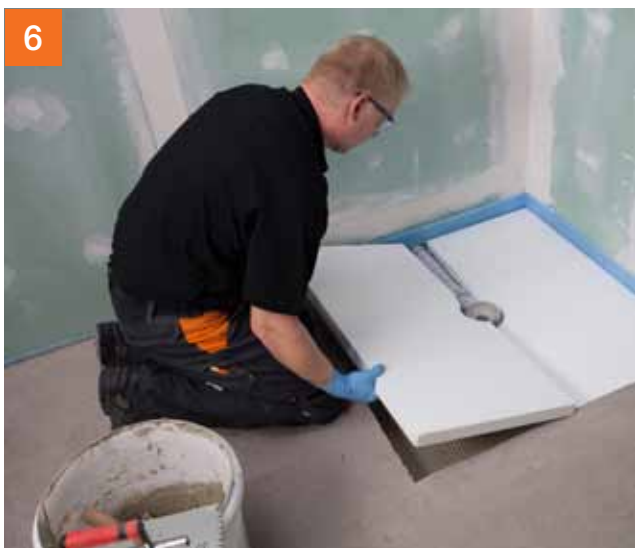
6 Verlijm de platen onderling met een flexibele mortel, bijvoorbeeld PCI Flexmörtel® S1.
