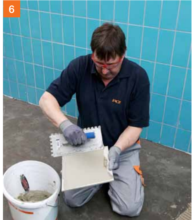
... wordt de buttering-floating-methode gebruikt.
