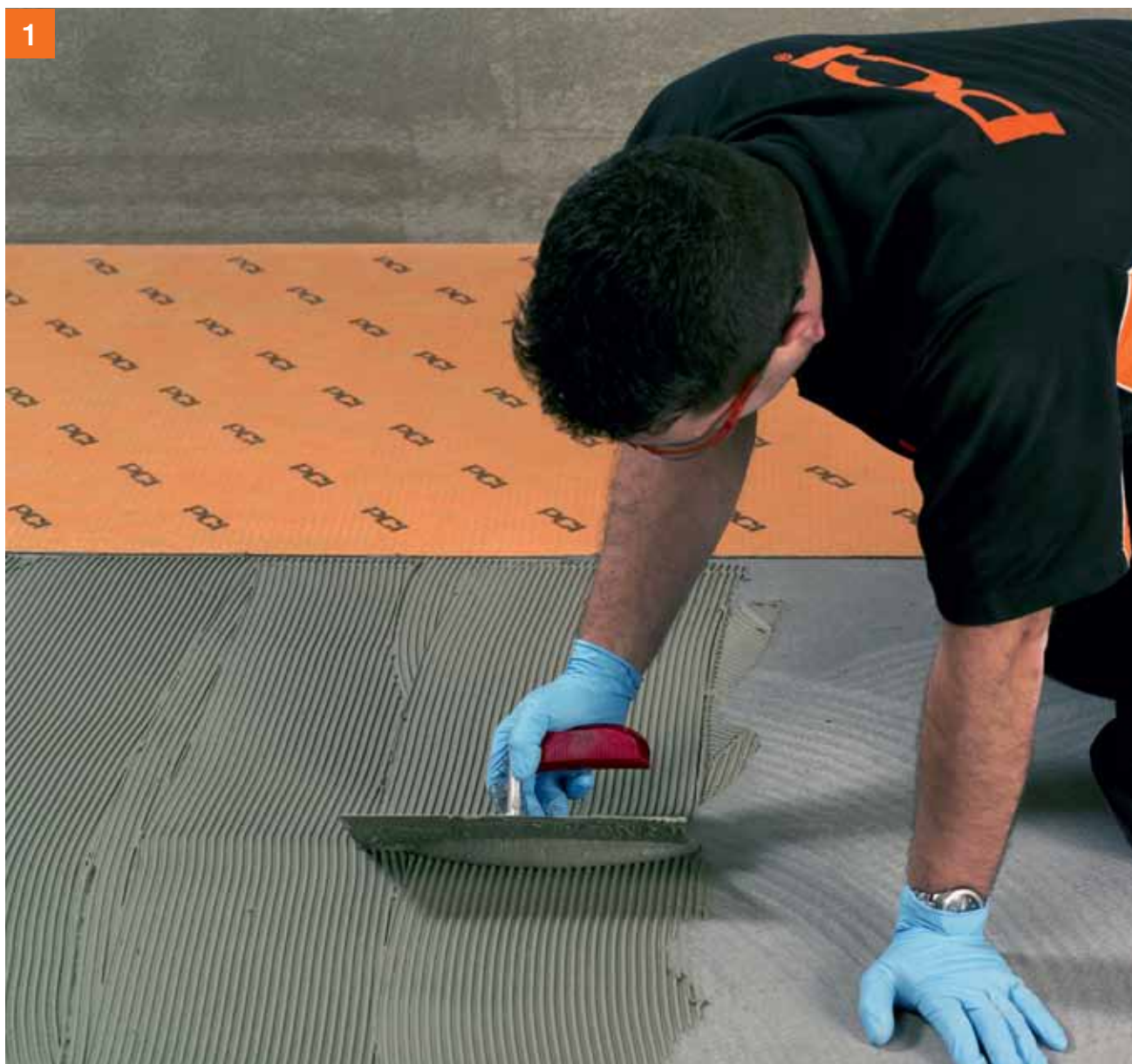
De afdichtingsmat PCI Pecilastic® op de ondergrond lijmen met PCI Flexmörtel® S2 of PCI Flexmörtel® S2 Rapid
