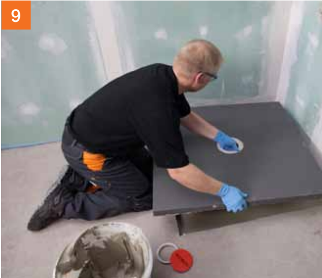
9 Plaats de PCI Pecibord*. Druk deze aan totdat de dichtring de rand van de vloerafvoer goed omsluit.
