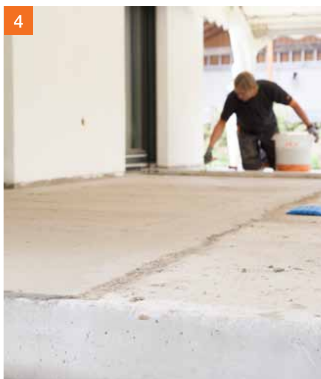
Met PCI Pericret® uitgevlakt vloergedeelte
