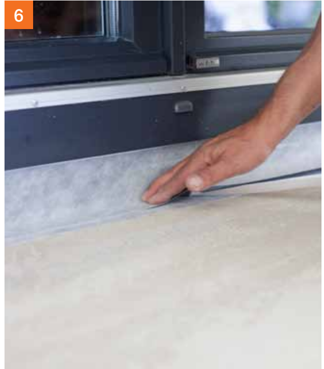
6 Optie 1: deurafdichting met PCI Pecitape® WS. Deze vooraf grondig reinigen
