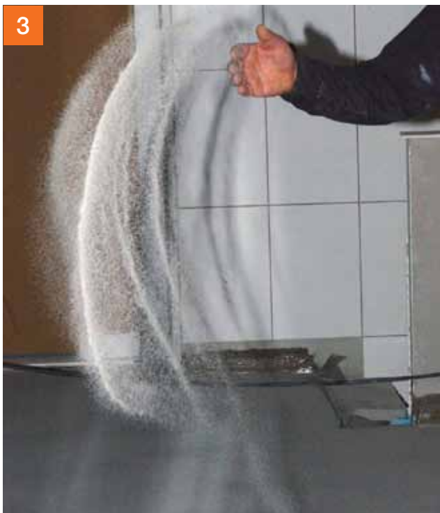
3 PCI Apoflex® vol en zat met kwartzand instrooien om de hechting met de tegellijm te verbeteren
