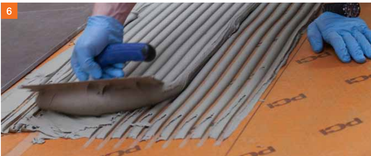
6 Tegels verlijmen met PCI Flexmörtel® S2 of PCI Flexmörtel® S2 Rapid.
