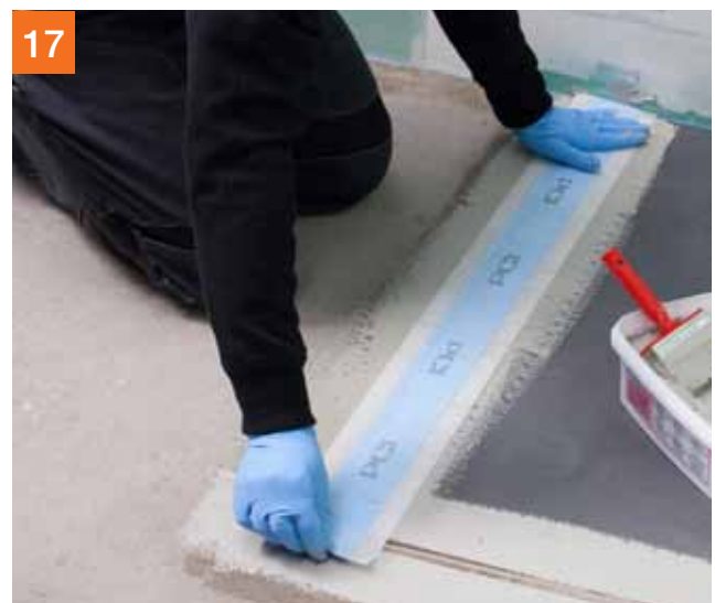
...PCI Pectape® 120 aanbrengen en aandrukken ...
