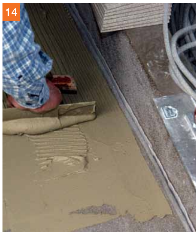
14 Tegellijm, bijv. PCI Nanoflott Light aanbrengen en opkammen
