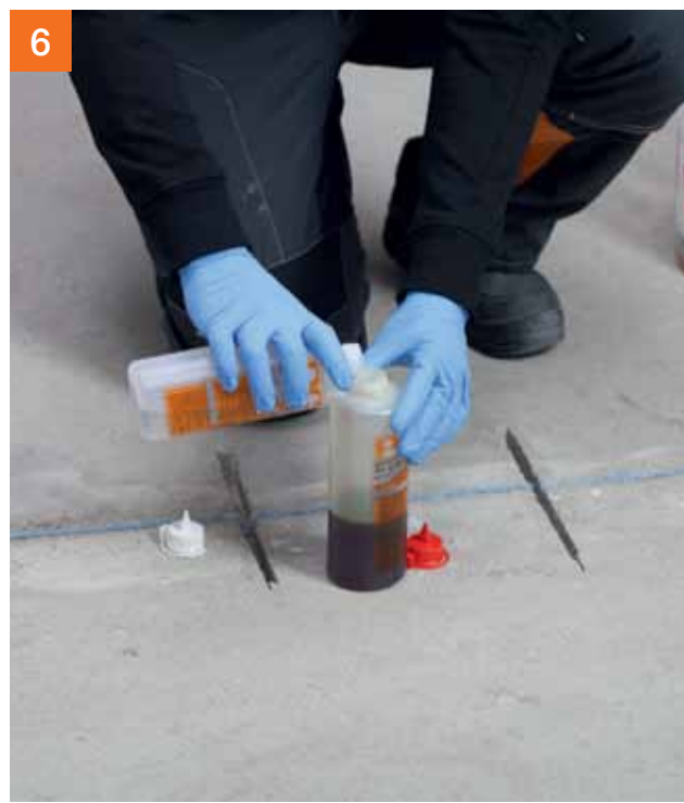
Zijn de sleuven voorbereid, dan worden de beide componenten van de PCI Apogel SH gemengd.
