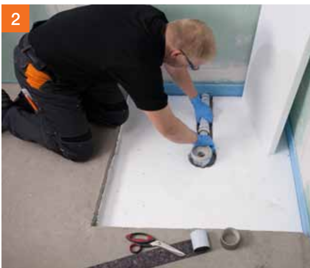
Sluit de afvoer aan op de bestaande afvoerpijp ...
