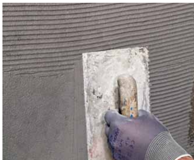
... en smeer de lijnrillen daarna gelijkmatig dicht.
