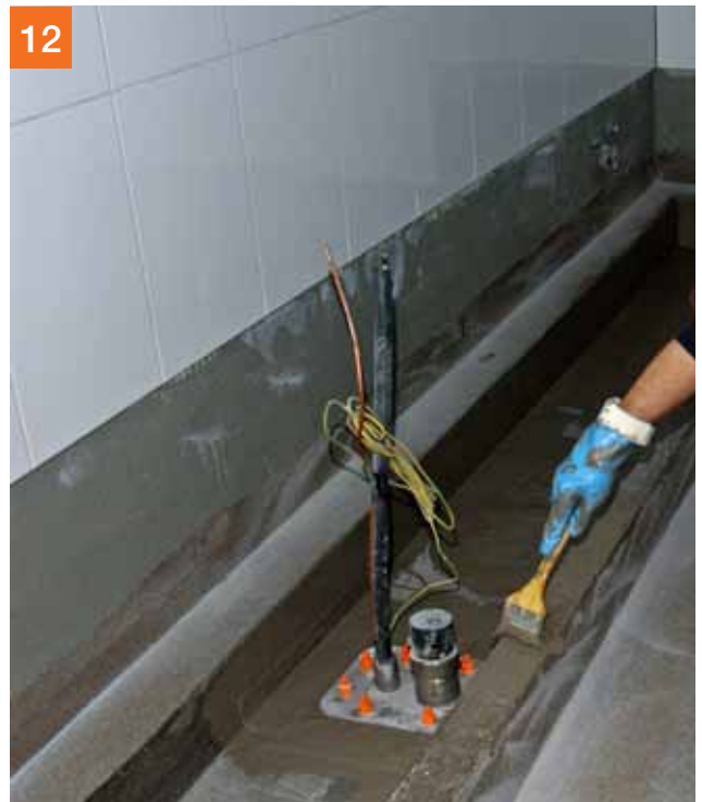
12 ... en doorvoeren met PCI Epoxigrund 390 gronderen
