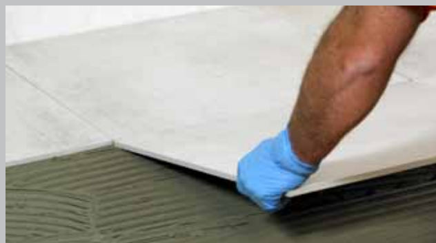
Ondergrondvoorbereiding voor het betegelen van de vloer en wand met grootformaat tegels en platen
