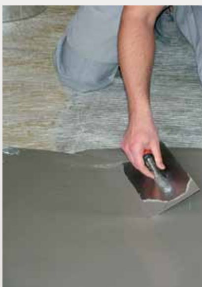
Met een spaan verdelen (geen rakel gebruiken!) ...
