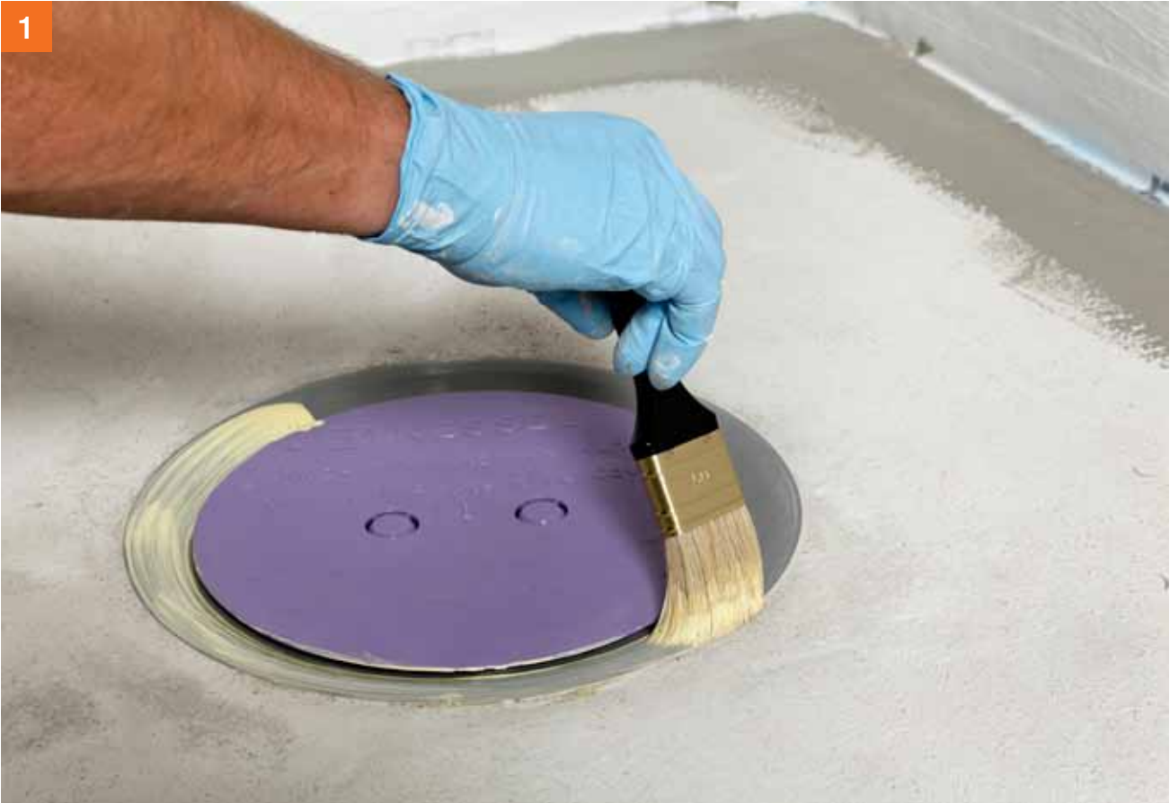
Grondeer de flens met PCI Gisogrund® 303 of PCI Gisogrund® 404.
