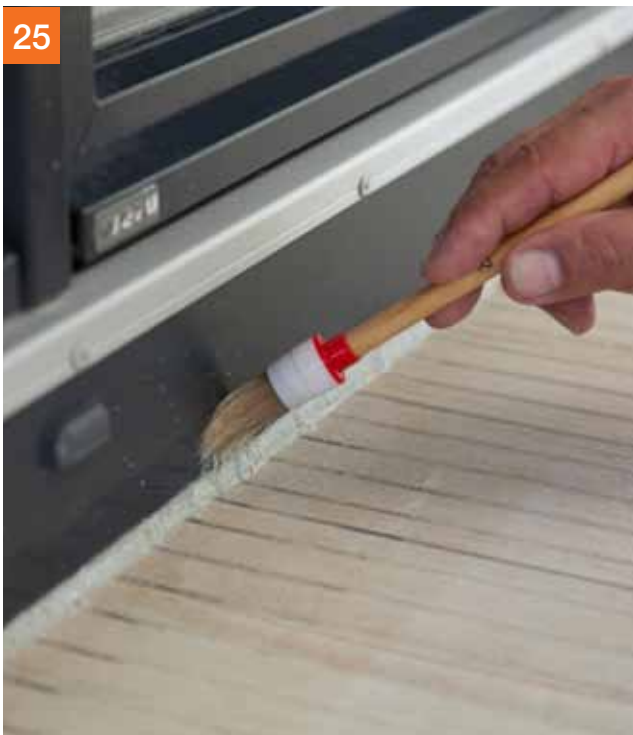
Om de siliconenkit eenvoudiger glad te strijken PCI Glättmittel aanbrengen ...
