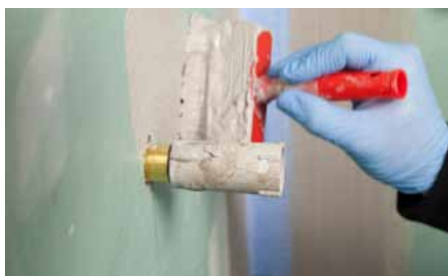
Voorbeelden van leidingdoorvoeropeningen.
