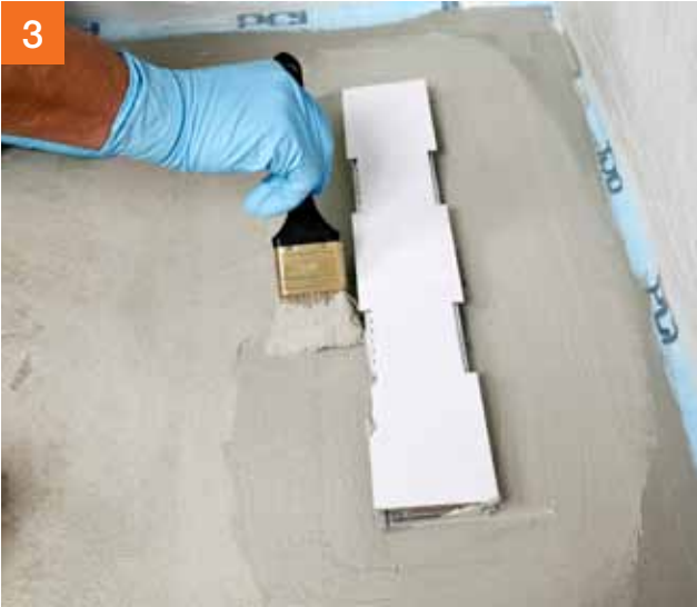
PCI Lastogum® of PCI Seccora® 2K Rapid als lijm aanbrengen voor het af fabriek meegeleverde manchetweefsel ...
