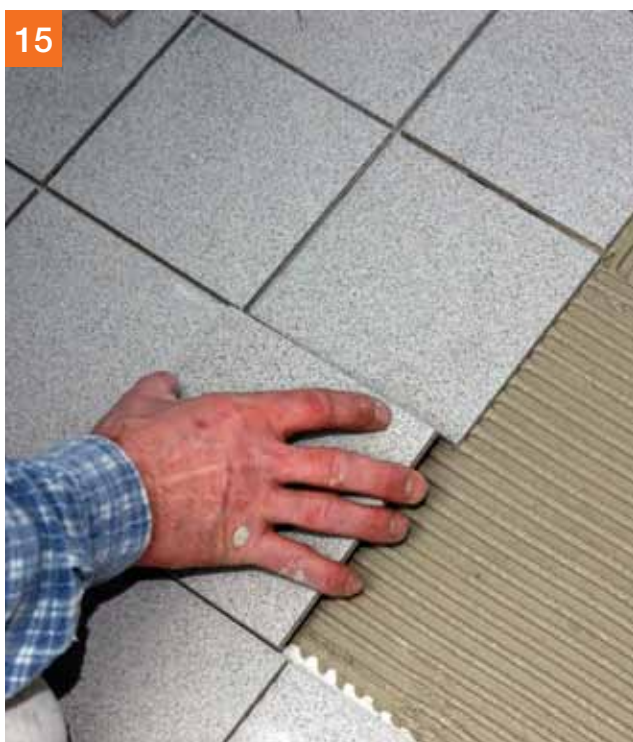
15 De tegels met een schuivende beweging op hun plaats brengen
