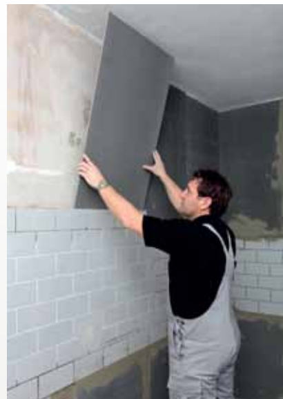
Plaats de PCI Pecidur®-bouwplaat en klop deze aan.
