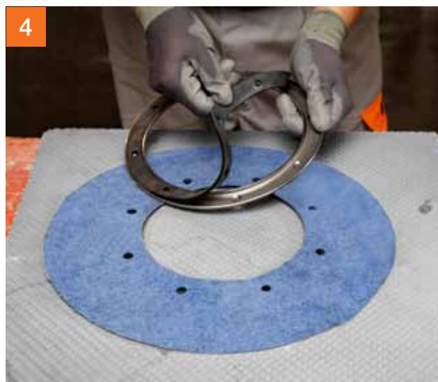
4 ... daarna de geprepareerde dichtmanchetten, het tweede afdichtingsrubber en de klemflens.
