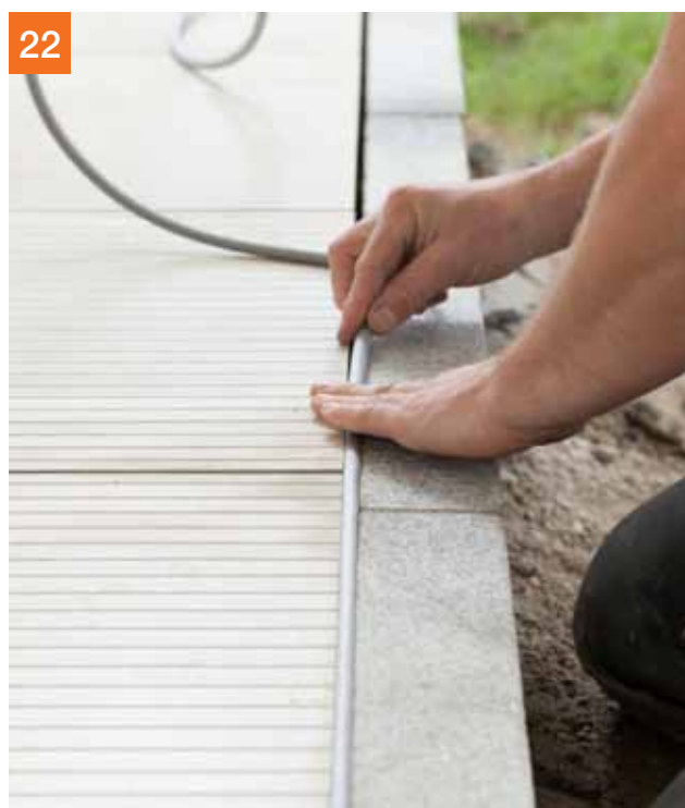
Rugvulling aanbrengen voordat wordt afgekit
