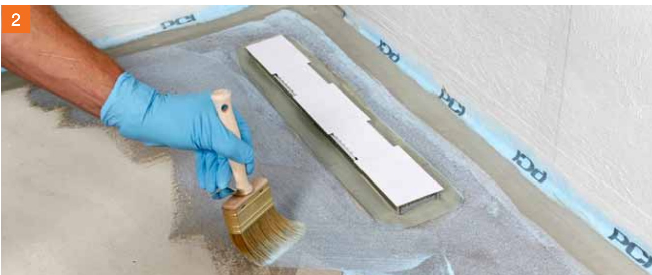
De rest van de vloer wordt met PCI Gisogrunder® gegrundeerd.
