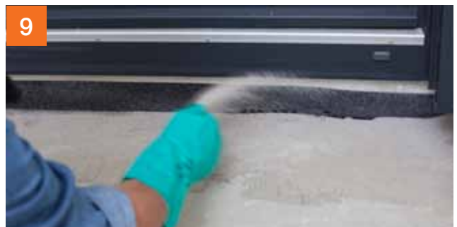
9 ... en in de verse grondering zand strooien.
