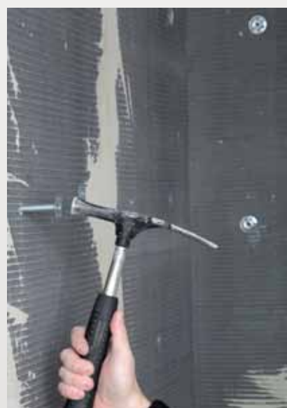
Sla daarna de pluggen in de gaten.
