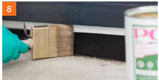
8 Gronderen met PCI Epoxigrund 390 ...
