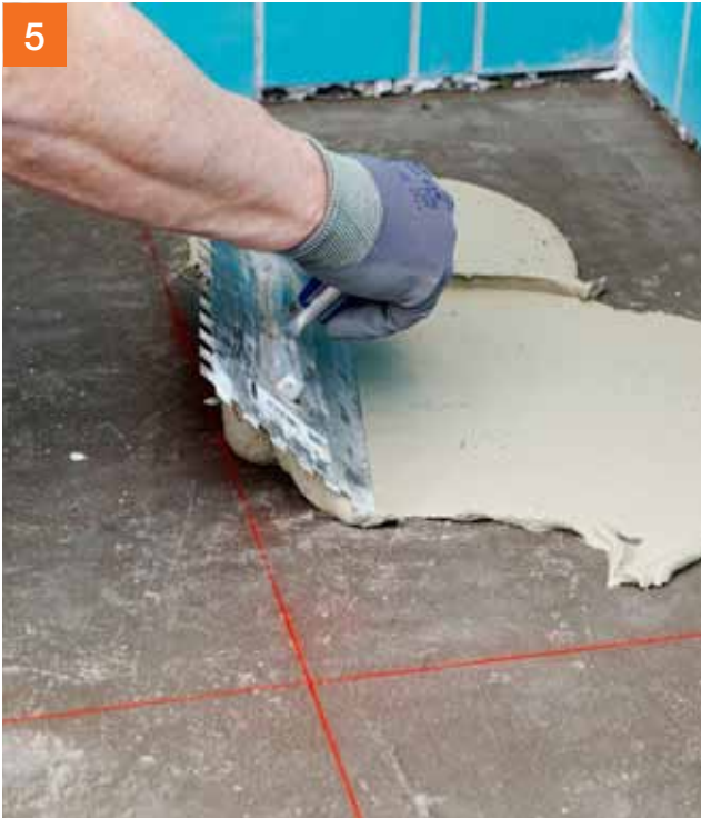
Ook bij het lijmen van de vloertegels ...
