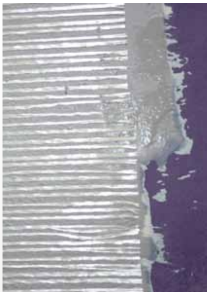
Ingelegde PCI Armiermatte GFS nadat de schutfolie is verwijderd.
