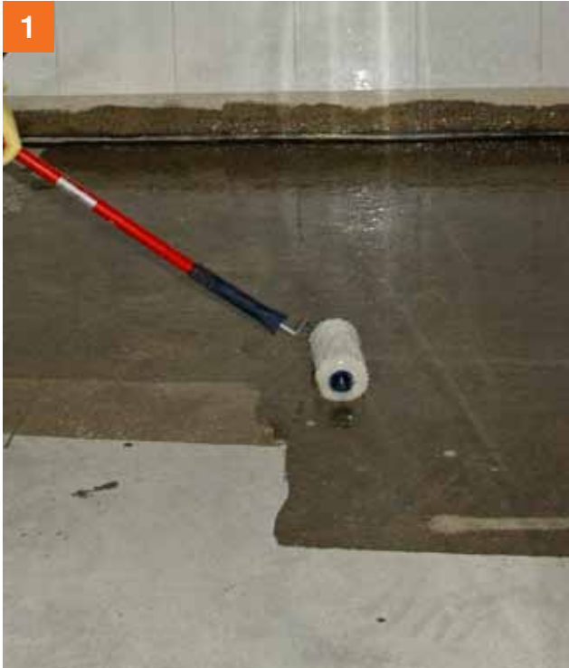
1 Ondergrond voorbehandelen, verontreinigingen en niet draagkrachtige gedeeltes verwijderen en uitvlakken. Met PCI Epoxigrund 390 gronderen.
