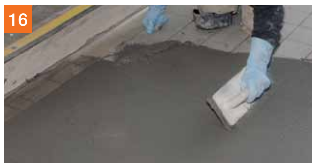
16 Afvoegen, bijv. met PCI Durafug® NT ...
