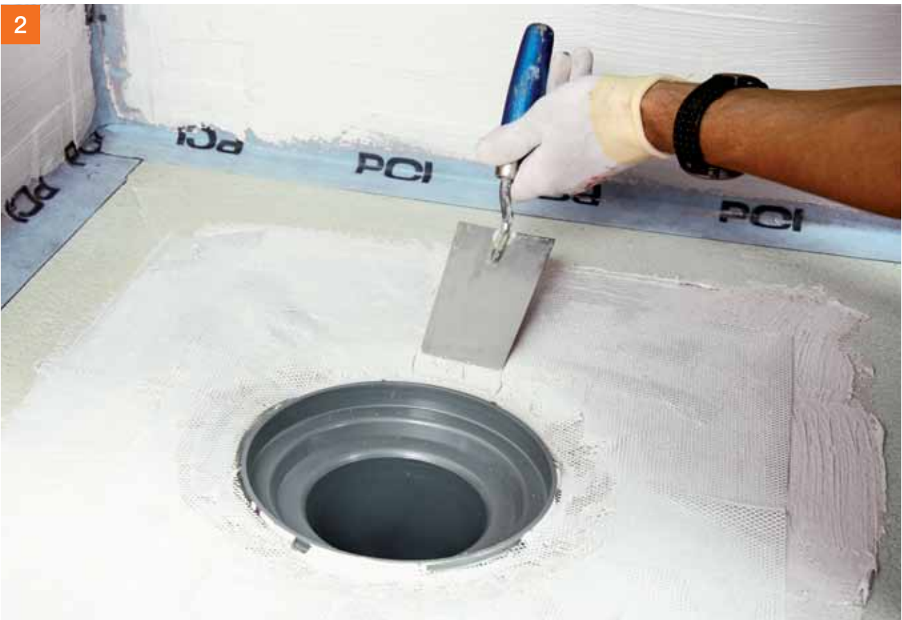
Leg het manchet met behoud van het afschot op de eerste laag PCI Lastogum® en druk het aan. Na uitharding (ca. 1 uur) een tweede laag PCI Lastogum® over het manchet aanbrengen.
