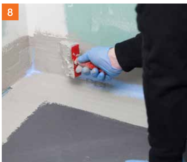
8 ... en smeer PCI Lastogum® op het vliesgedeelte van de kimband.
