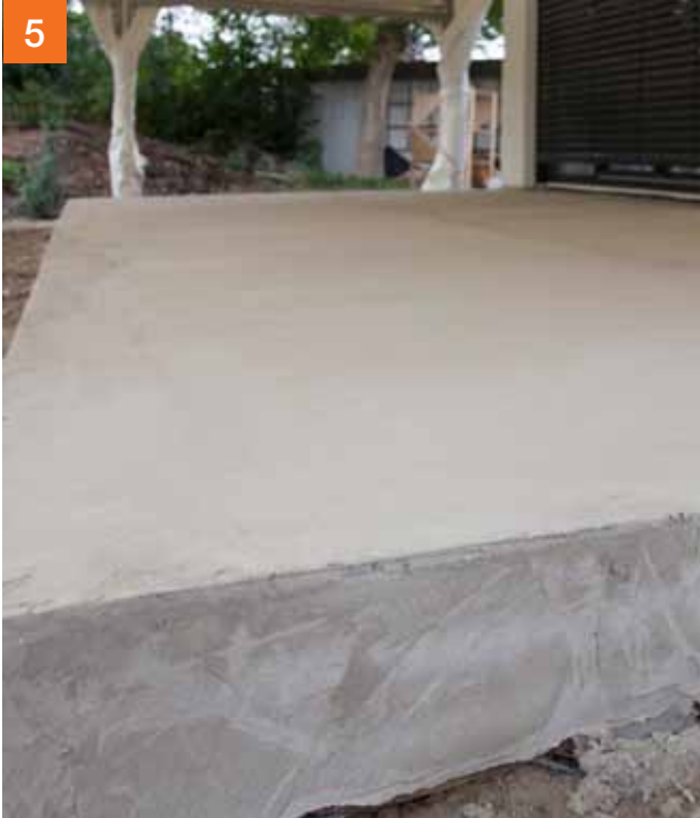
5 Terrasvloer, uitgevlakt met PCI Pericret®
