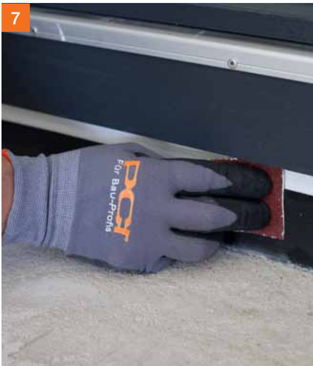
7 Optie 2: deurafdichting met PCI Pecitape® 120: Rand lichtjes schuren en dan reinigen met PCI Univerdünner.
