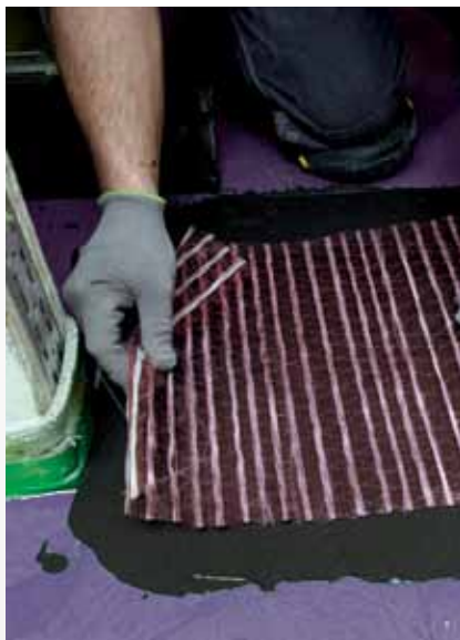
Leg de glasvezelstrengen van de versterkingsmat PCI Armiermatte GFS in de verse spachtel.
