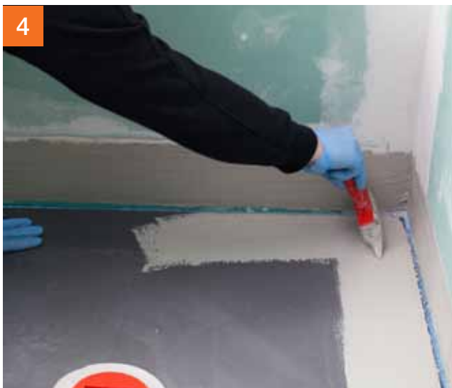
4 Daarna wordt PCI Lastogum® ook op de vloer aangebracht. Nog steeds de randstrook vrij laten
