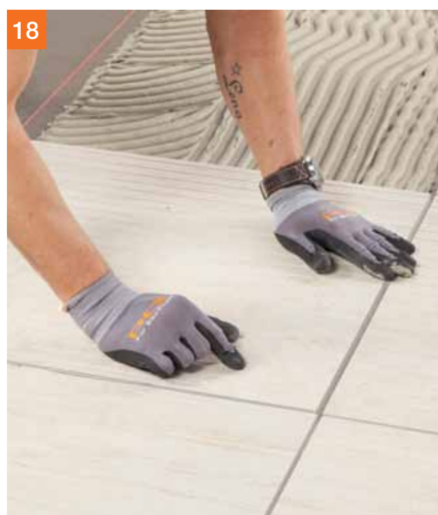
Tegels inschuiven en zo nodig met een gummihamer aankloppen, daarna uitrichten.
