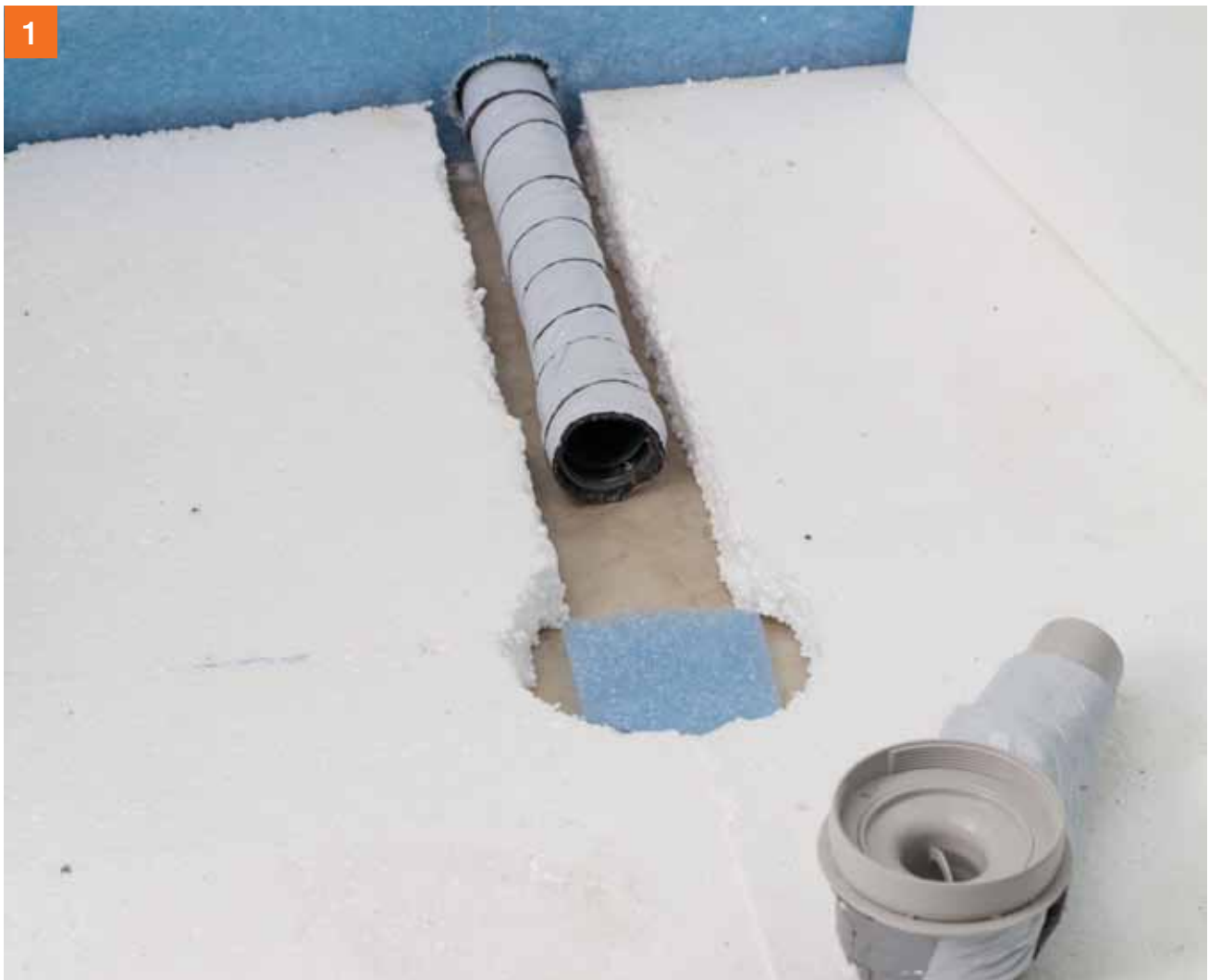
PCI Pecibord® kan op een drukvaste hardschuimplaat van polystyrol worden aangebracht als deze met volledige dekking op de ondergrond is gelijmd.
