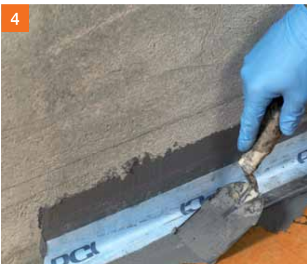
4 Aansluitingen met PCI Seccoral® 2K Rapid ...
