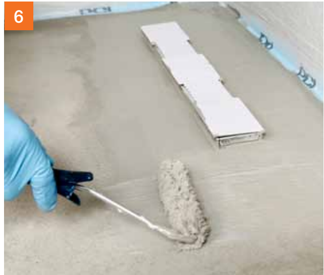
Daarna komen rond de goot twee lagen van een waterafdichtingslaag.
