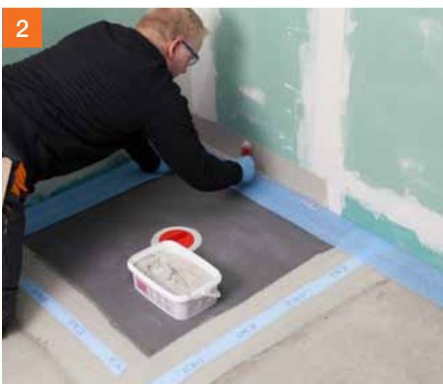
Kimband PCI Pecitape® 120 zal worden gelijmd met afdichtingspasta PCI Lastogum®. Deze pasta wordt nu eerst op de wand aangebracht.
