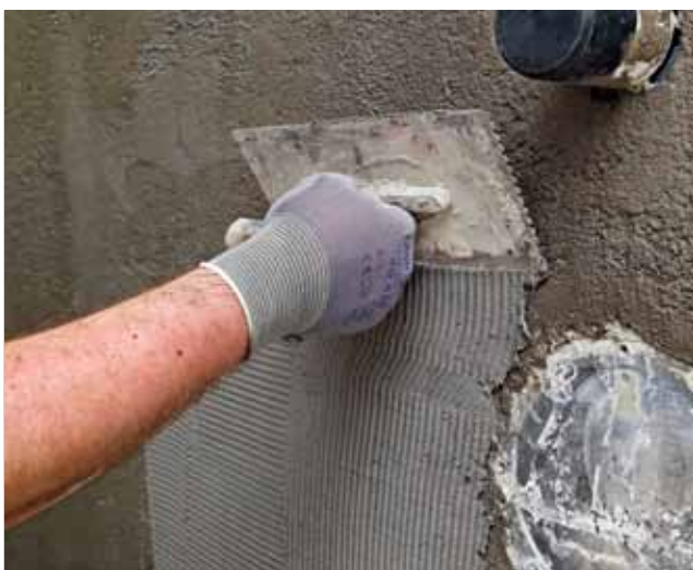
Breng de 1e laag PCI Seccoral® 2K Rapid aan met een lijnkam (6 mm) ...
