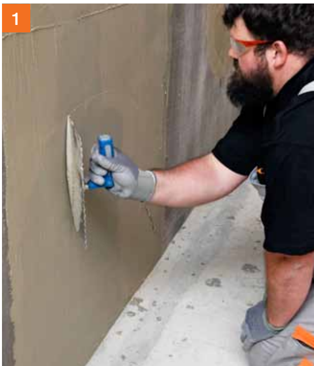
1 Breng PCI FT® Klebemörtel met toegevoegd PCI Lastoflex® zeer dun aan.
