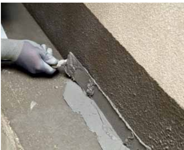
Voor het afdichten van hoeken (bijvoorbeeld wand-/vloeraansluitingen) wordt eerst PCI Seccoral® 2K Rapid aangebracht ...
