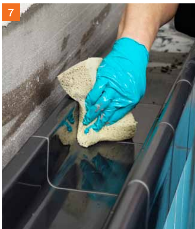
Als de randstenen zijn gezet, en de lijm is uitgehard, de stenen afvoegen met bijvoorbeeld met PCI Durafug® NT of PCI Durapox® NT Plus.
