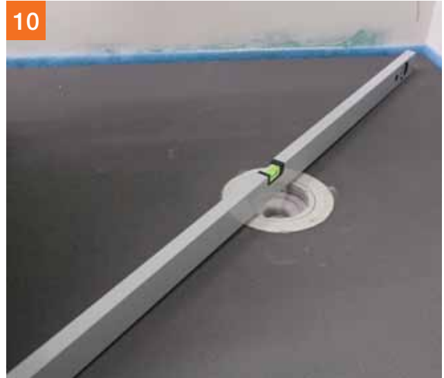
10 Controleer met een waterpas of de inbouw correct is en ...
