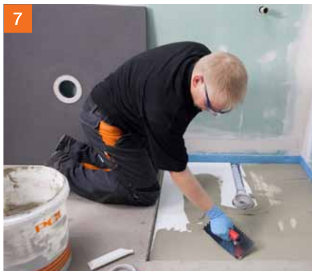
7 Breng tegellijm aan om de PCI Pecibord® met de onderplaat te verlijmen.
