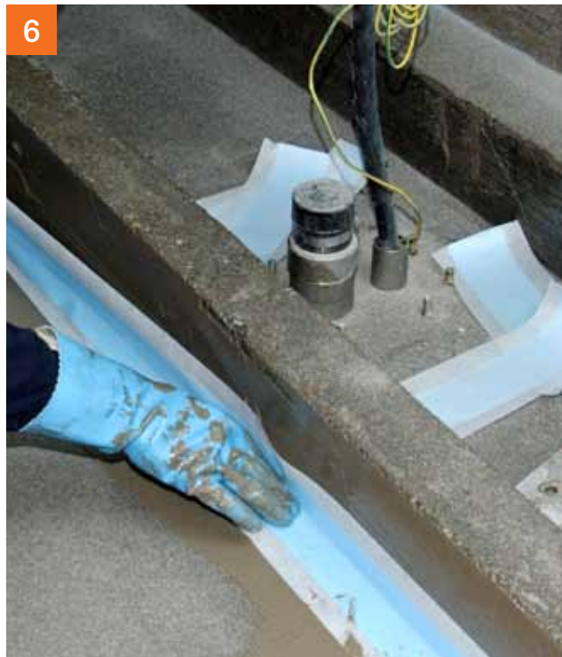
6 ... dan kimband PCI Pecitape® 120 of PCI Pecitape® Objekt inbedden en afwerken met PCI Apoflex®
