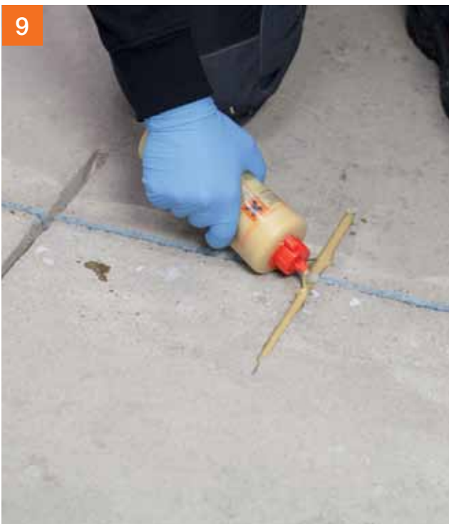
Daarna de gleuf geheel met PCI Apogel SH volgieten ...
