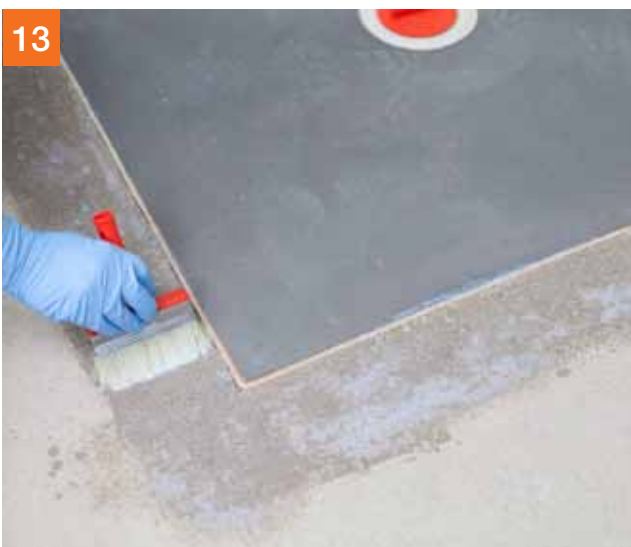
13 Grondeer een strook van de dekvloer die grenst aan de doucheplaat met PCI Gisogrund*.
