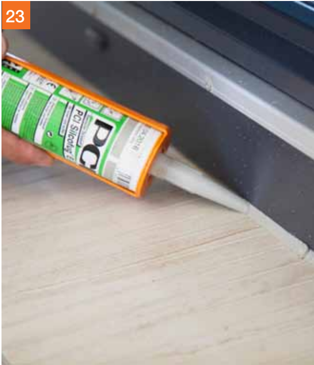
Aansluiting met het venster afkitten met PCI Silcofug® E of PCI Silcoferm® S
