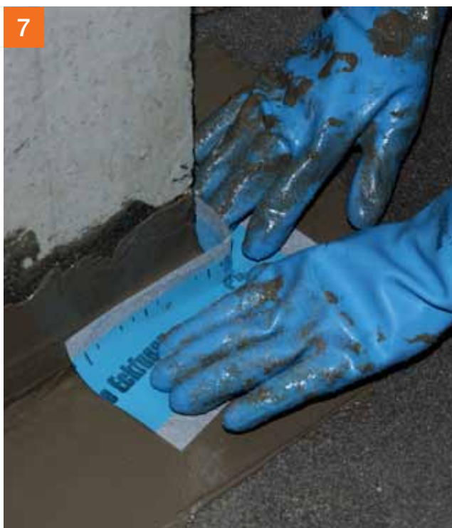
7 PCI Pecitape® 90° op de afdichtingslaag leggen...
