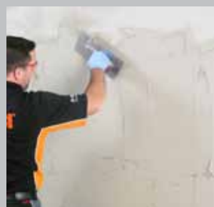
Ondergrondvoorbereiding voor het betegelen van de vloer en wand met grootformaat tegels en platen
