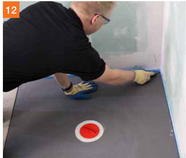
12 Snij de randstrook af, gelijk met de bovenkant van de PCI Pecibord*.
