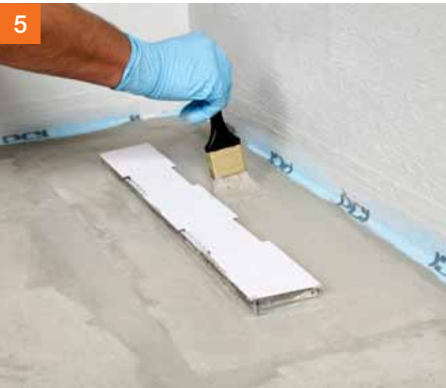
... afdichtingsmateriaal ook over het manchet aanbrengen.
