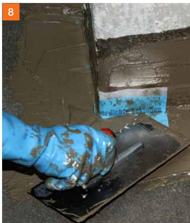
8 ... en voldoende PCI Apoflex® daarover aanbrengen
