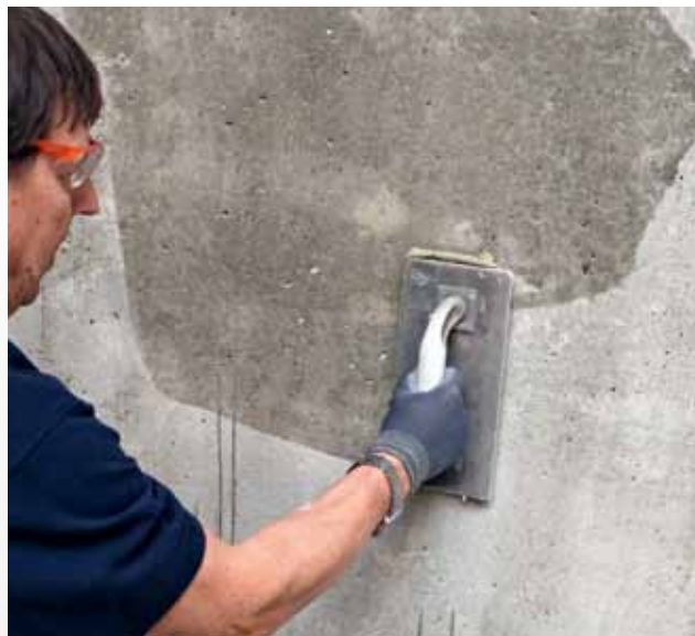
Bevochtig de ondergrond lichtjes om de wateropname te reguleren of grondeer met PCI Gisogrund® of PCI Gisogrund® 404, afhankelijk van de toepassing.
