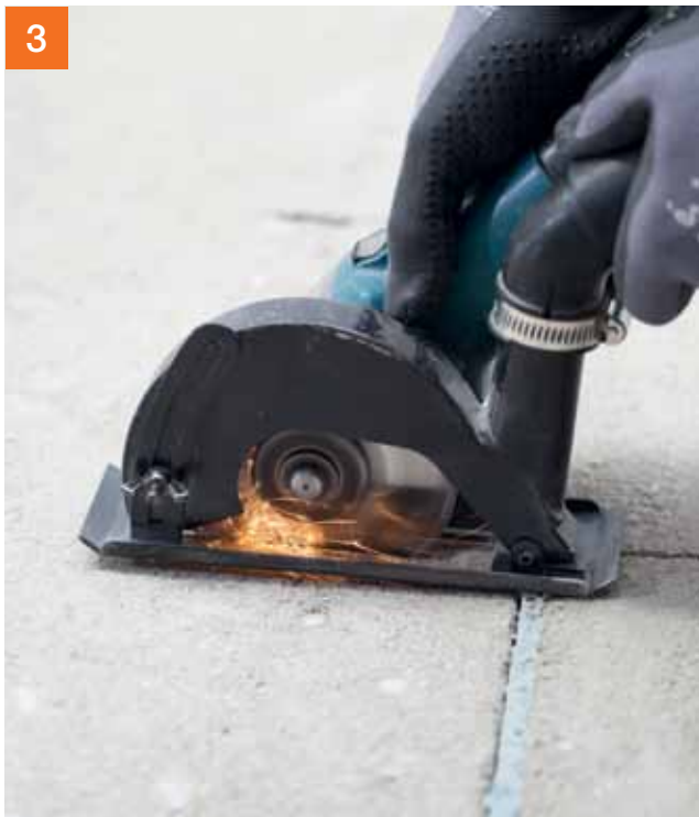
Dan met een slijptol deze plekken inzagen...
