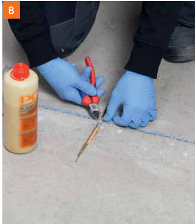
PCI Apogel pluggen in de gleuf aanbrengen en de elastische ring doorknippen.
