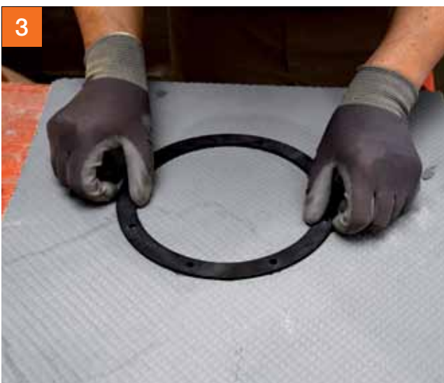
3 Het eerste afdichtingsrubber wordt nauwkeurig aangebracht ...
