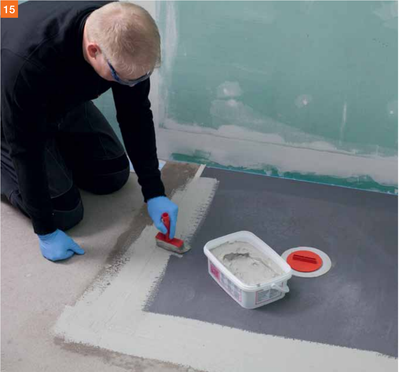
Breng PCI Lastogum® aan als lijm voor de kimbanden ...
