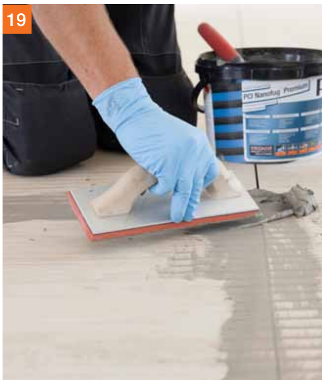
Tegels afvoegen met PCI Nanofug® Premium ...
