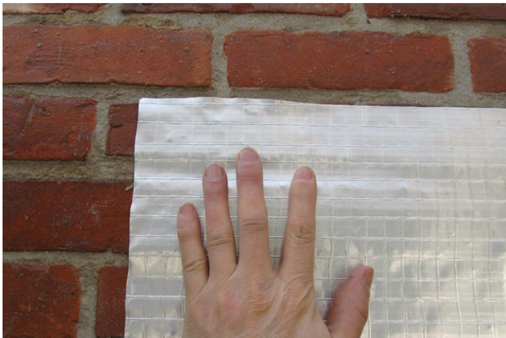
Reaxyl® Benfoil 31 aandrukken in de verse Reaxyl® ZX-345 steenstriplijm.
