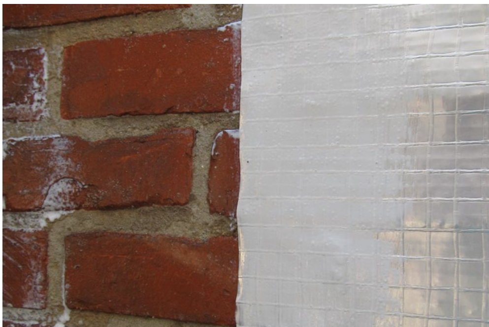
Naden en aansluitingen 5 – 10 cm overlappen met Reaxyl® Foliad.
