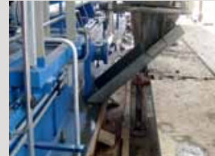
Materiaal tot aan overloop aan de tegenoverliggende zijde vullen.
