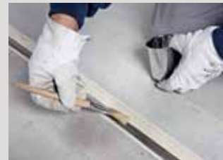
Aanbrengen van primer op de voegoppervlakken en verdampingstijden in acht nemen. Hier: PCI Elastoprimmer 110 bij zuigende ondergrond ca. 60 minuten. Letten op gelijkmatig aanbrengen van de voegkit.
