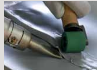
De lasverbinding van afdichtbanden en het vastlijmen van diagonale verbindingen gebeurt met behulp van een heteluchtpistool. De elasticiteit moet gewaarborgd zijn.
