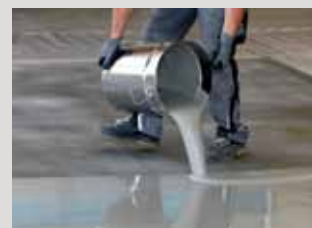
Aanbrengen van de vloeibare beschermingslaag.
