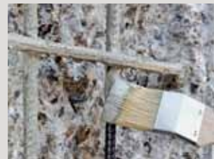
De actieve wapeningsbescherming PCI Nanocret® AP in ten minste twee lagen met volledige dekking aanbrengen.
