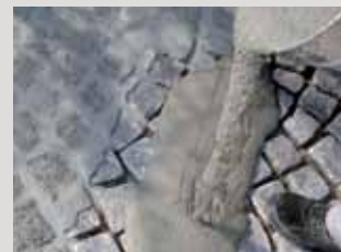
Aanbrengen van de drainerende bestratingsvoegmortel PCI Pavifix® 1K Extra op het vooraf bevochtigde natuursteenoppervlak.
