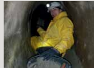
Aanbrengen van het sulfaatbestendige afdichtingslaag PCI Barraseal bij riolerings.
