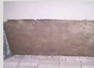
Machinaal aanbrengen van afdichtpleister aan binnenzijde kelder en bij een sokkel van een gevel.
