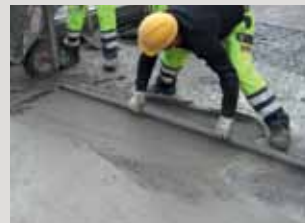
Egalisatie van een vloeroppervlak met PCI Repafast® Tixo.
