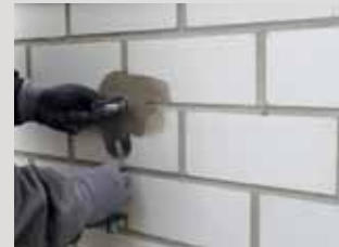
Zetten van moffen en verankeren van inbouwdeelen met behulp van cementshoudende mortels, zoals PCI Repafix®.
