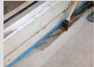
Het aanbrengen van een primer met PCI PUR-Grund vereenvoudigt het aanbrengen van de schraaplaag.
