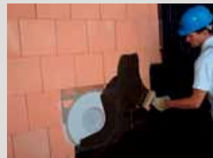
Afhankelijk van de belasting, bitumen afdichting in één of twee lagen aanbrengen.
