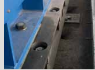
Bekisting aanbrengen, materiaal gelijkmatig van één zijde in de bekisting gieten, zodat lucht volledig kan ontsnappen.
