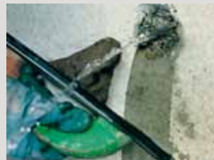
PCI Polyfix® 30 sek. als snelciment voor het snel afdichten van lekkages.
