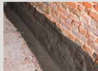
Kelderafdichting aan binnenzijde met cementhoudende afdichtingslaag PCI Barraseal®.
