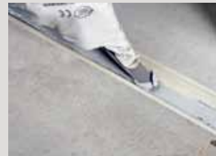
Verwijderen van overtollig voegmateriaal en glad strijken.
