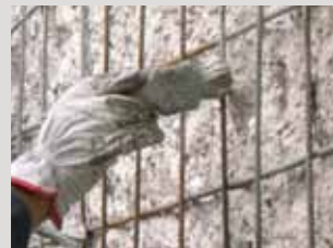
Voorbehandelen van de wapeningsstaven met actieve wapeningsbescherming PCI Nanocret® AP.
