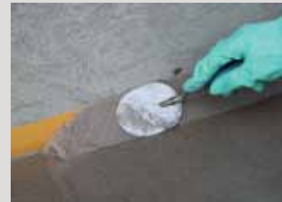
Maken van een holle plint van PCI Bauharz gemengd met kwartszand.
