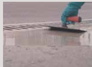
Afwerking bij een afvoergoot met epoxygietmortel PCI Repaflow® EP Plus.
