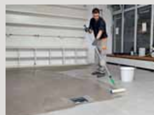
Na ca. 1 dag kunnen cementhoudende vloeregalisatiemortels worden afgewerkt met een eindverzegeling, bijv. PCI Zemtec®.
