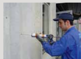
Opvullen en vastzetten van verankeringen met methacrylaat PCI Barrafix® 920.
