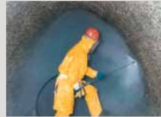
Voorbehandelen van een beschadigd betonoppervlak in een riool.
