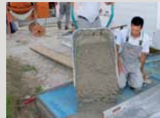
Aanbrengen van de monokorrelmortel PCI Pavifix® DM op een ondersteunende drainmat.
