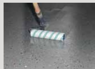
De ingestrooide kleurchips moeten met PCI Pursol® transparent verzegeld worden. Bij coatings zonder kleurchips kan de tweede laag worden aangebracht met PCI Pursol® 1K farbig (gekleurd).
