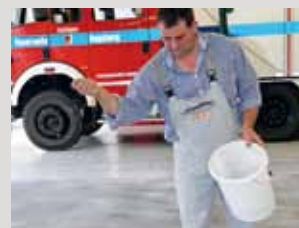
Strooien van kleurchips op de nog natte beschermingslaag.
