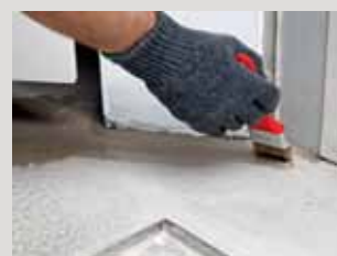
Handmatig aanbrengen van de matte eindverzegeling PCI Finopur®.
