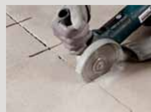
Dekvloer dwars t.o.v. werkvoeg inslijpen, uitzuigen en verankeringshaken resp. PCI Apogel® Dübel (pluggen) plaatsen.
