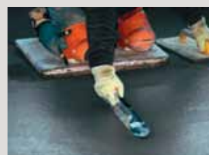
Dekvloerooppervlakken glad maken met een troffel of betonpolijstmachine.
