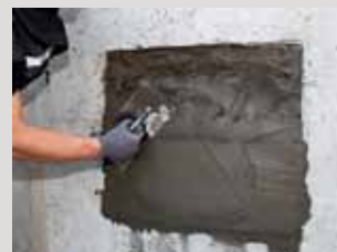
De zeer sterke reparatiemortel, bijv. PCI Nanocret® R4, vol en zat en zonder holle ruimten met de hand of machinaal aanbrengen.
