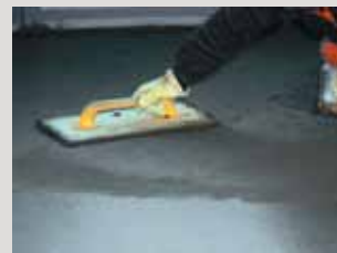
Eventueel onder de scheidingslaag een egalisielaag aanbrengen.
