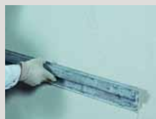
Bij een hoge zout- en/of vochtbelasting is verwerking in twee lagen vereist.
