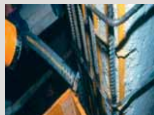
Aanbrengen van hoge sterkte, vloeiend PCI Nanocret® R4 Fluid in een gedeelte met hoge wapeningsdichtheid.
