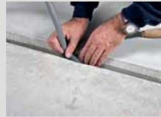
Ter voorkoming van een drieflanken-hechting een geslotencellige O-ring met de juiste grootte plaatsen.
