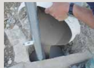
Vastzetten van inbouwdeelen met cementgebonden PCI Verguss-Fix.
