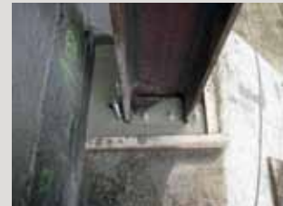
Ingieten van een steun met PCI Repaflow®.
