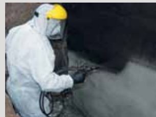
Grondering van een zuigende ondergrond met PCI Pecimor® F.
