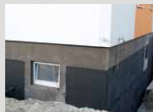
Overgang van een bitumen afdichting met PCI Seccoral® 2K Rapid boven het maaiveld.
