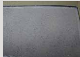
De eerste laag PCI Pursol® 1K wordt ingestrooid met PCI Farbchips 05 graniti.
