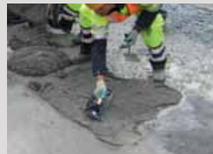
Vloerreparatie van een gat met niet vloeiende PCI Repafast® Tixo.
