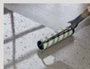
Aanbrengen van een UV-stabiele eindverzegeling, bijv. PCI Finopur®.
