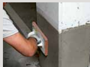
Dichtsmeren van holle ruimtes met fijne plamuur PCI Nanocret® FC.
