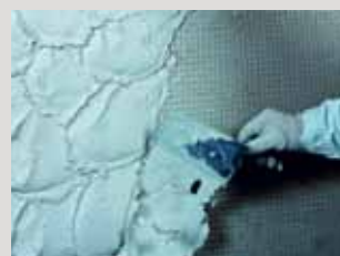
Op vochtig, zouthoudend metselwerk kan de verwerking in één laag gebeuren met saneringspleister PCI Saniment® Super.
