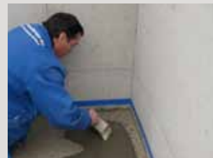
Bij gebruik als verbindingslaag moet een hechtbrug van PCI Repahaft® worden aangebracht.
