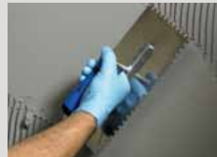
Aanbrengen van de flexibele, scheuroverbruggende afdichting PCI Seccoral® 2K Rapid.
