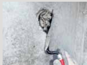
Opvullen van ontbrekende gedeelten met PCI Polyfix® 5 min. of PCI Repafix®.
