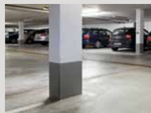
Pijler bewerkt met fijnkorrelige plamuur PCI Nanocret® FC.
