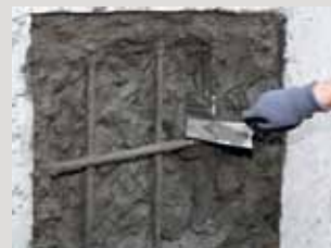
Contactlaag met de eerste laag reparatiemortel aanbrengen met borstel, kwast of troffel.
