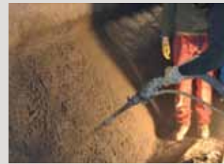
De sulfaatbestendige reparatiemortel PCI Nanocret® R4 kan zowel handmatig als machinaal worden aangebracht.
