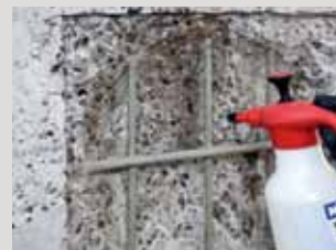
Voorafgaand aan de betonsanering oppervlakken tot matvochtig voorbevochtigen, eventueel gronderen met PCI Nanocret® AP.
