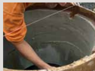
Bekleden van een schachtring en zetten met PCI Polyfix® Plus L.
