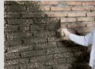
Aanbrengen van een spatlaag met toevoeging van PCI Emulsion.
