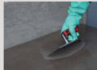
De porievrije schraaplaag bestaande uit PCI PUR-Grund gemengd met kwartszand 0,05 – 0,20 maakt een stevige hechting en een uitharding zonder luchtballen van de volgende beschermingslaag mogelijk.
