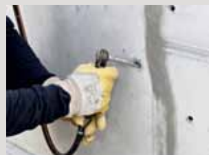
De zelfafdichtende packer stevig vastdraaien in het eerder gereinigde boorgat.
