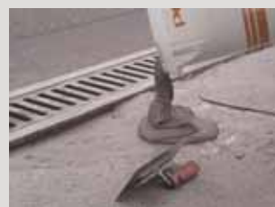
Vloeiende egalisatie van een betonnen vloeroppervlak met PCI Repafast® Fluid.
