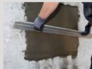
De reparatieoppervlakken vlak afwerken en na korte wachttijd verdichten of schuren.
