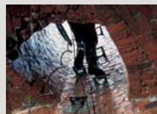
Aanbrengen en vastzetten van stijpijzers in riolerings en navoegen van klinkers met PCI Polyfix® Plus.
