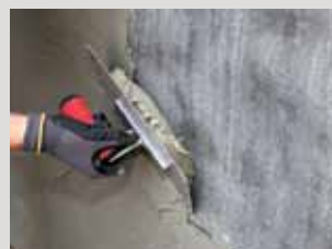
Aanbrengen van de vezelversterkte plamuur PCI Nanocret® FC.
