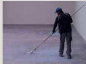
Voorafgaand aan het toepassen van de vloeiende egalisiemortel de hechtprimer PCI Gisogrund® 404 aanbrengen.
