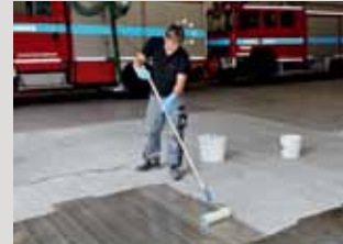
Gronderen van het voorbehandelde oppervlak met epoxyhars, bijv. PCI Epoxigrund 390.
