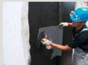
Aanbrengen van een PCI-Gewebebahn bij een buisdoorvoer.
