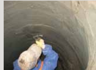
Maken van een gelijkmatige ondergrond met PCI Nanocret R4®.
