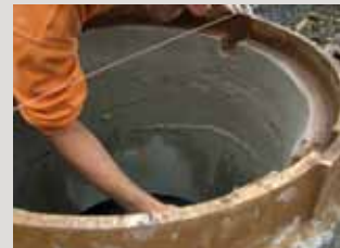
Bepfeisteren en zetten van een schachtring met PCI Polyfix® Plus L.
