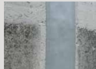
Afdichten van twee geprefabriceerde bouwelementen met PCI Pecitape®.
