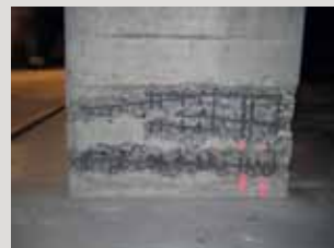
Vrijmaken van door chloride aangetast beton in een garage.
