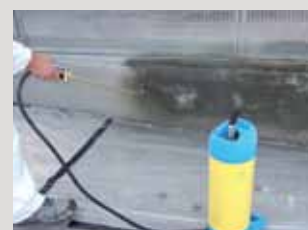
Handmatig aanbrengen van een PCI Silconal®-hydrofobering als niet-filmvormende water- en vuilafstotende laag.
