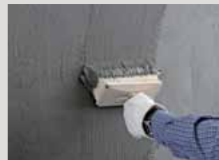
Aanbrengen van het cementhoudende, sulfaatbestendige afdichtingslaag PCI Barraseal.
