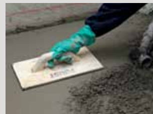
De snelle dekvloer PCI Novoment® moet vers op de hechtbrug worden aangebracht.
