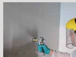
Machinaal aanbrengen van PCI Polyflex® voor het afdichten van scheuren en als bescherming tegen carbonatatie van een betonnen parkeergaragewand.
