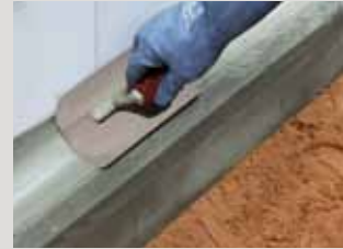
Van scherpe randen met reparatiemortel PCI Nanocret®/PCI Polyfix® een holle plint maken.
