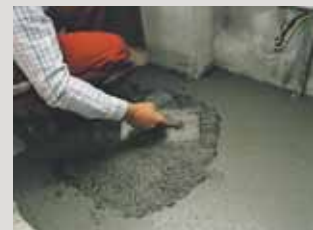
Aanbrengen van een spatlaag met toevoeging van PCI Emulsion.
