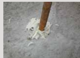
Opvullen van boorgaten met cementgebonden PCI Verguss-Fix.
