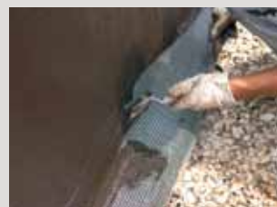
Afwerken waar water doordringt, op holle plinten en voegen met PCI-Gewebebahn resp. PCI Pecitape® 250.
