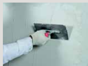
Door middel van een dunne laag fijne pleister ontstaat een glad oppervlak.
