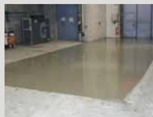
Egalisatie van een betonnen vloer met goed vloeiende dekvloer PCI Zemtec® 180.
