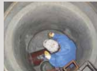
Aanbrengen van een cementhoudende afdichtingslaag PCI Barraseal® in een regenwaterbak.
