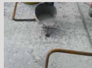
Opvullen van boorgaten met cementgebonden PCI Verguss-Fix.
