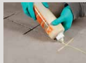
PCI Apogel® in een patroon vullen, mengen en gelijkmatig in de geprepareerde voeg aanbrengen.
