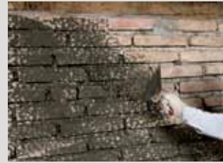
Bij het saneringspleistersysteem wordt spatlaag PCI Saniment® HA netvormig met een dekkingsgraad van ca. 50 procent opgebracht.
