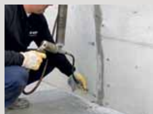
De injectiehars van onder naar boven tot volledige verzadiging injecteren.
