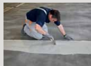
Handmatig afwerken van een uitzevoeg.
