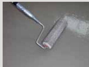
Het materiaal gelijkmatig verdelen en met een stekelwals ontluften.
