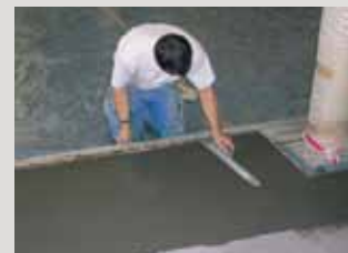
Met toeslagmiddelen zoals PCI Estrifix® en PCI Dichtungsmittel worden de verwerking en de eigenschappen van traditionele cementshoudende dekvloeren verbeterd.
