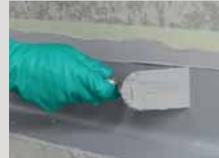
Het afdichtband PCI Pecitape® 3000 zorgvuldig aandrukken en met een troffel gladstrijken.
