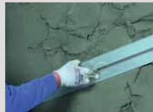
Bij het saneringspleistersysteem wordt spatlaag PCI Saniment® HA netvormig met een dekkingsgraad van ca. 50 procent opgebracht.
