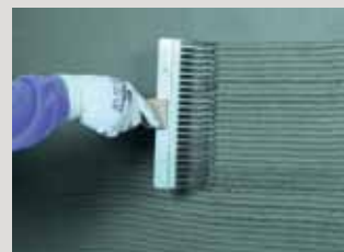
De dampremmende en afdichtende pleister PCI Saniment® DP kan zowel handmatig als machinaal worden opgebracht. Voor een goede hechting van volgende lagen wordt het oppervlak opgeruwd met een pleisterkam.
