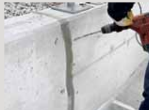
Element schuin t.o.v. scheurrichting afwisselend rechts en links inboren. Het boorgat moet de scheur ongeveer in het midden kruisen.
