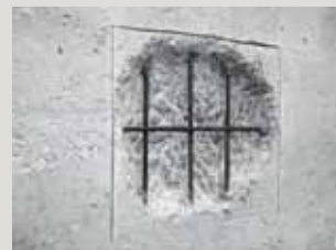
De wapeningsstaven ontdoen van roest en oude verflagen.
