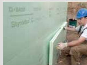
PCI Pecimore® DK over het volledige oppervlak op de isolatieplaat aanbrengen en deze vastlijmen. Boven de grondwaterspiegel kan ook met dotten worden gelijmd. De naden van de afzonderlijke platen met PCI Pecimor® DK dichtplamuren.
