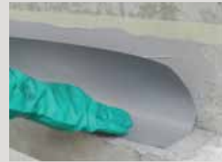
Epoxy-bouwlijm PCI Barrafix® EP gelijkmatig aanbrengen en het afdichtband plaatsen.
