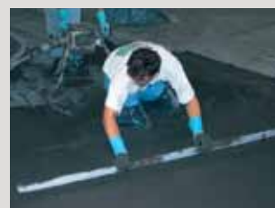
Dekvloeren op isolatie- en scheidingslagen moeten in homogene laagdikten worden aangebracht..
