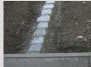
Zetten van bestratingsstenen, randstenen en perkomrandingen met PCI Pavifix® USM.
